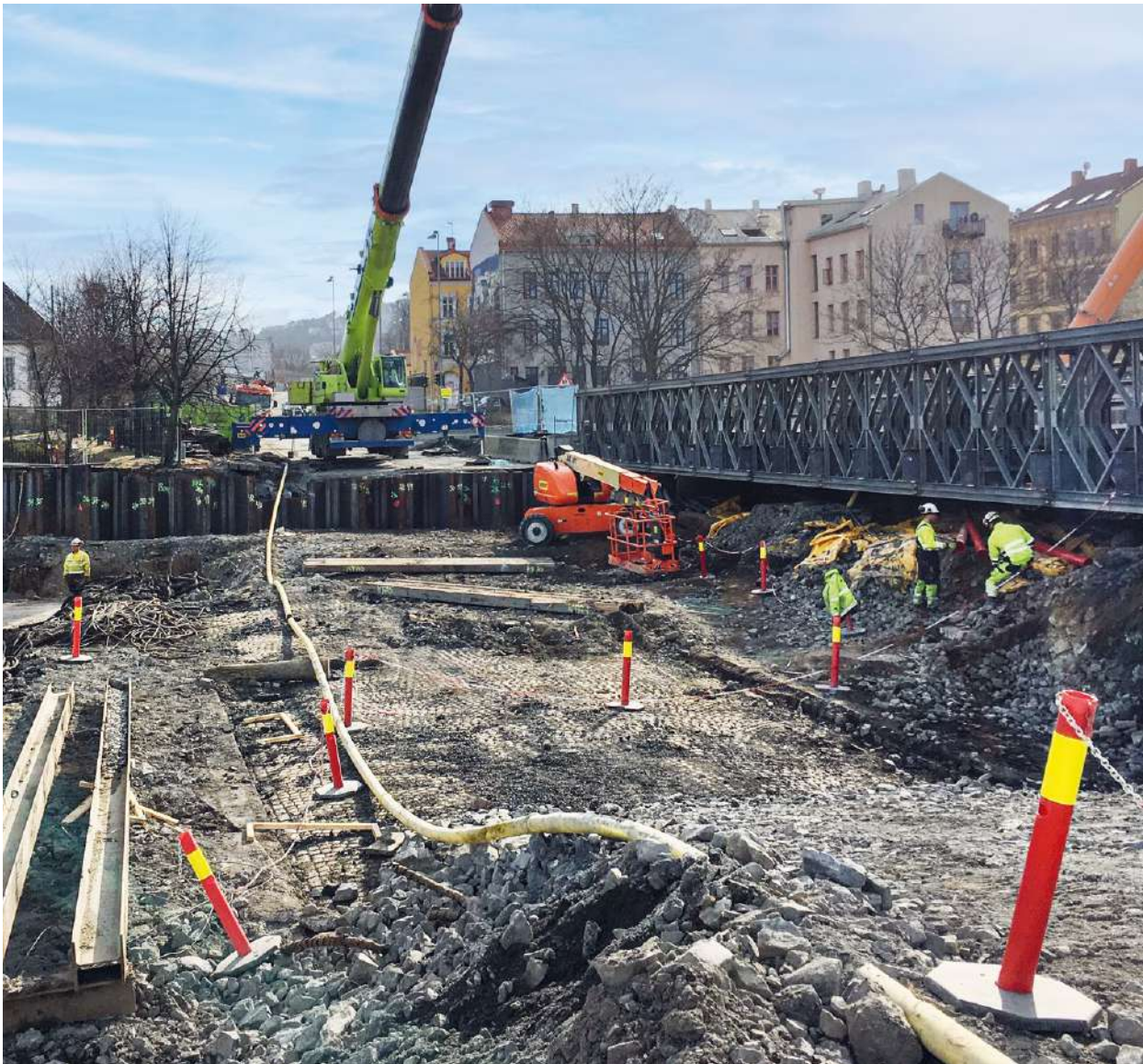
FIGUR 3.4.13 Brostein fra tidlig 1900-tall ble avdekket ca. 1,5 meter under asfalten i Bispegata. Til høyre i bildet sees en midlertidig bro over deler av utgravningsområdet, plassert for å tilrettelegge for kontinuerlig trafikk gjennom utgravningsperioden. Gata har dermed vært i kontinuerlig bruk gjennom over tusen år.
