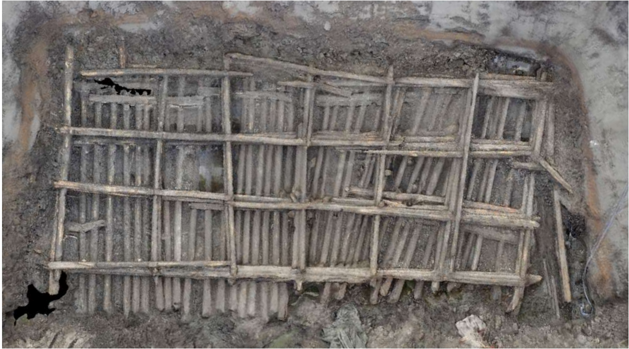
FIGUR 3.4.9 På 1590-tallet ble det bygd en rekke brygger med noen meters avstand mellom. Bryggene var fundamentert på løst laftet tømmerbolverk lagt på flåter og anlagt med langsiden mot land. Denne bryggen (K11 fra B3/B7-tomten) ble oppført i ca. 1592 og kan sees i figur 3.4.8. Fotogrammetri ved Khalil Olsen Holmen, Norsk Maritimt Museum. Lisens: CC BY-SA 4.0.
