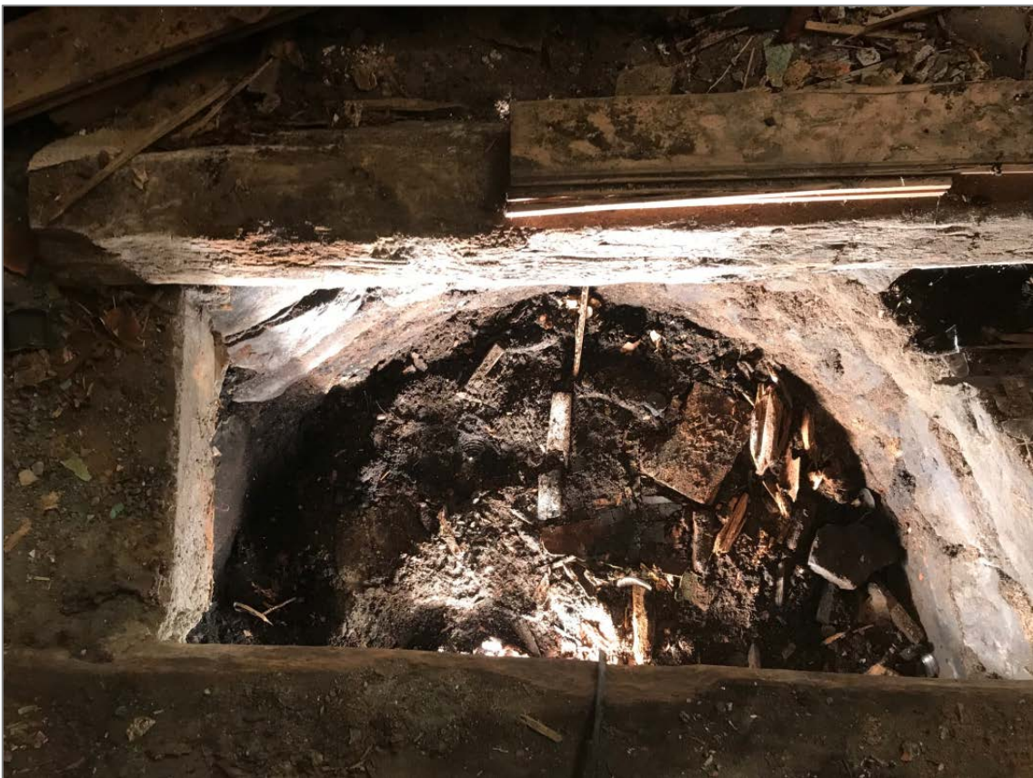
Figur 3. Brønnen. Foto: Bergli, 9. nov. 2018
