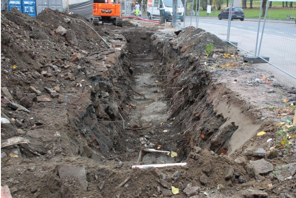
Figur 67: Grøft 2, søndre del, sett mot nord. Foto-nr: niku_ark_ 327109
