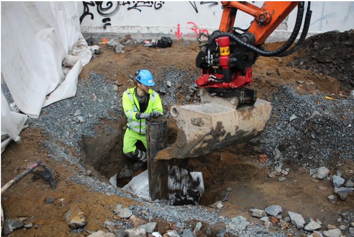
Figur 7: Egil Lindhart Bauer under påfylling av oppgravde masser – her i grop 3. Sett mot sør. Foto-nr: niku_ark_327458
