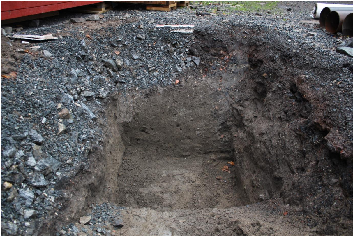
Figur 17: Grop 1 etter endt utgraving. Gropa er gravd ned til 160 cm. Kirkegårdslaget fortsatte nedover, men det var ingen synlige graver. Sett mot vest. Foto-nr: niku_ark_327433
