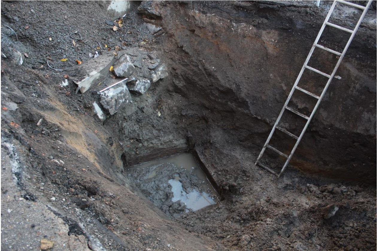
Figur 61: Brønn og mur i grøft 1. Av sikkerhetshensyn er grøftkantene skrånede i øvre del. Sett mot nordøst. Foto-nr: niku_ark_327119
