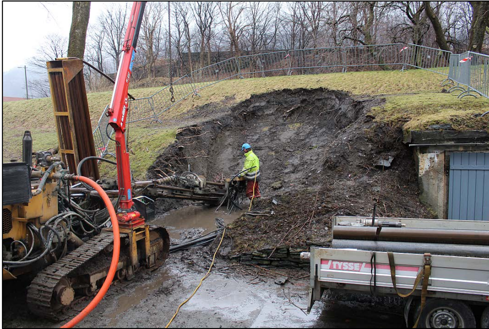
Figur 2. Hullet for boreriggen på innsiden av festningsmuren (bildenr.: niku_ark_335300).
