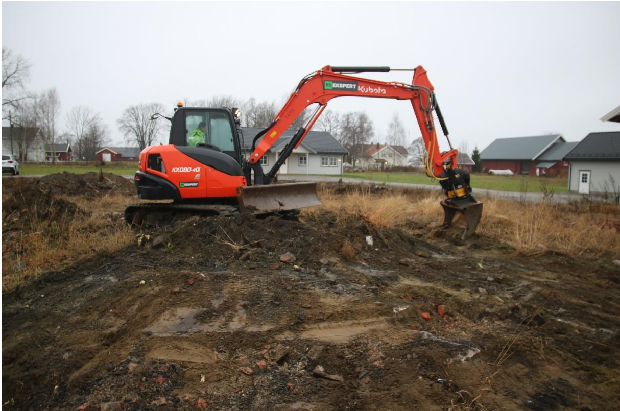
Figur 4: Flaten nord for kjellergropen ved oppstart av arbeidet. Sett mot nordvest. Foto: Cf54078_NIKU_01.
