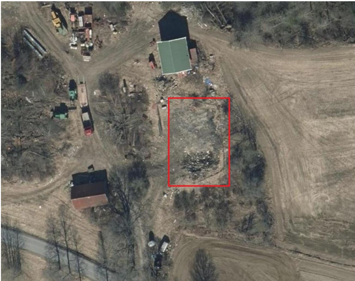
Figur 2: Våningshuset på tomten er brent ned, og rivningsmasser og byggegrop etter kjeller står igjen.
