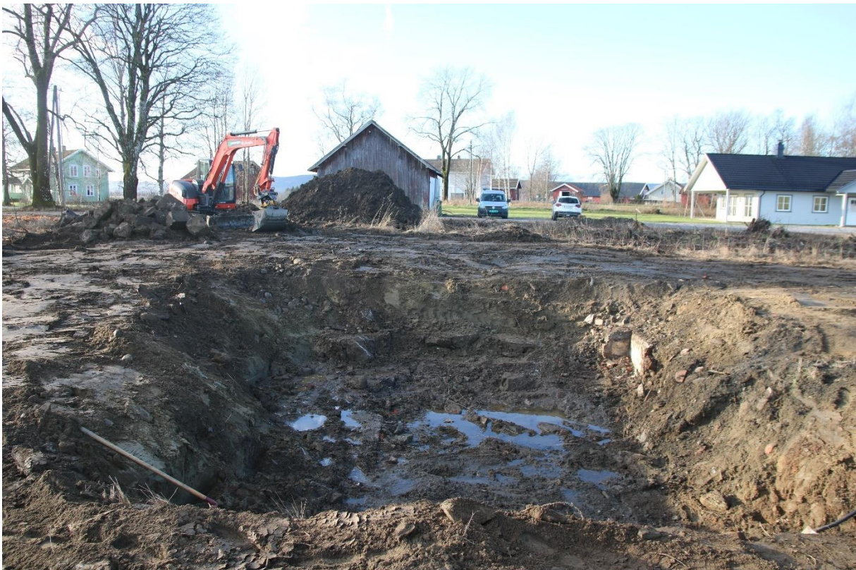
Figur 7: Kjellergrøpen underveis i oppryddingsarbeidet. Sett mot vest. Foto: Cf54078_NIKU_17.
