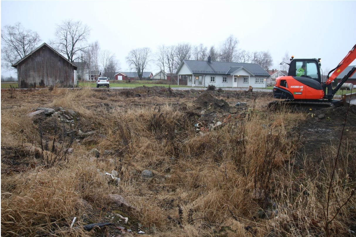
Figur 6: Kjellergrøpen før oppstart av arbeidet. Sett mot nordvest. Foto: Cf54078_NIKU_03.
