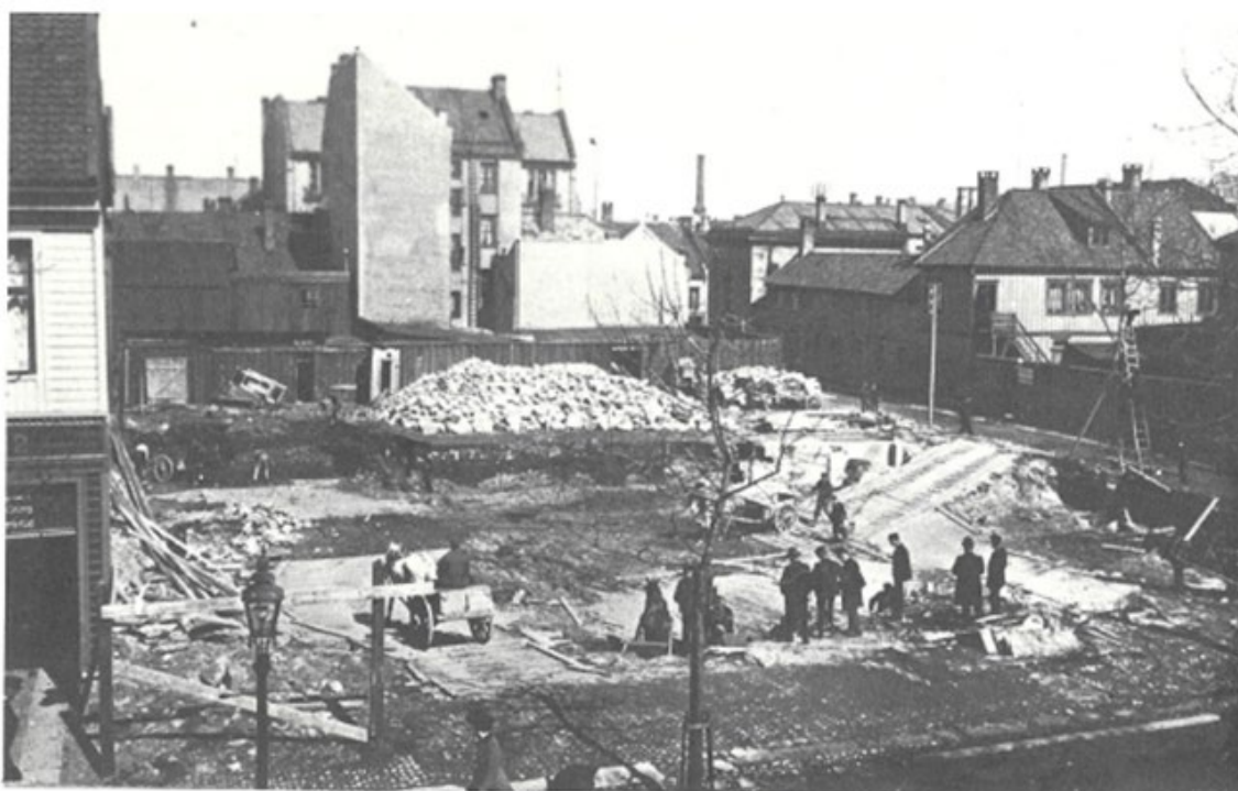
Figur 5: Foto fra etableringen av Posthuset på eiendommen Dronningens gate 10 tidlig på 1900-tallet. Fotoet er tatt mot nordøst, og det er Apotekerveita man ser til høyre i bildet. I nord er profilene med bevarte kulturlag eksponert, og den lyse sanden i bunnen representerer trolig den naturlige undergrunnssanden på stedet. Foto fra Lunde 1977: 35, fig. 16.
