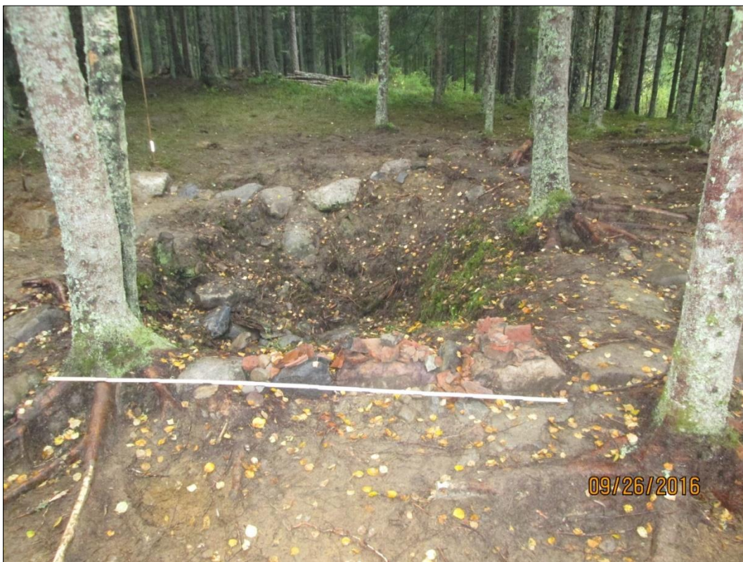
Figur 15 Søndre del av kammerset i forgrunnen, stuerommet med kjeller bakenfor. Veggskillet (nordre grunnmur til stuerommet) mellom de to rommene ligger like på linje med tommestokken. Mot S (foto 30 i fotoliste 2016). Foto: NIKU 2016.
