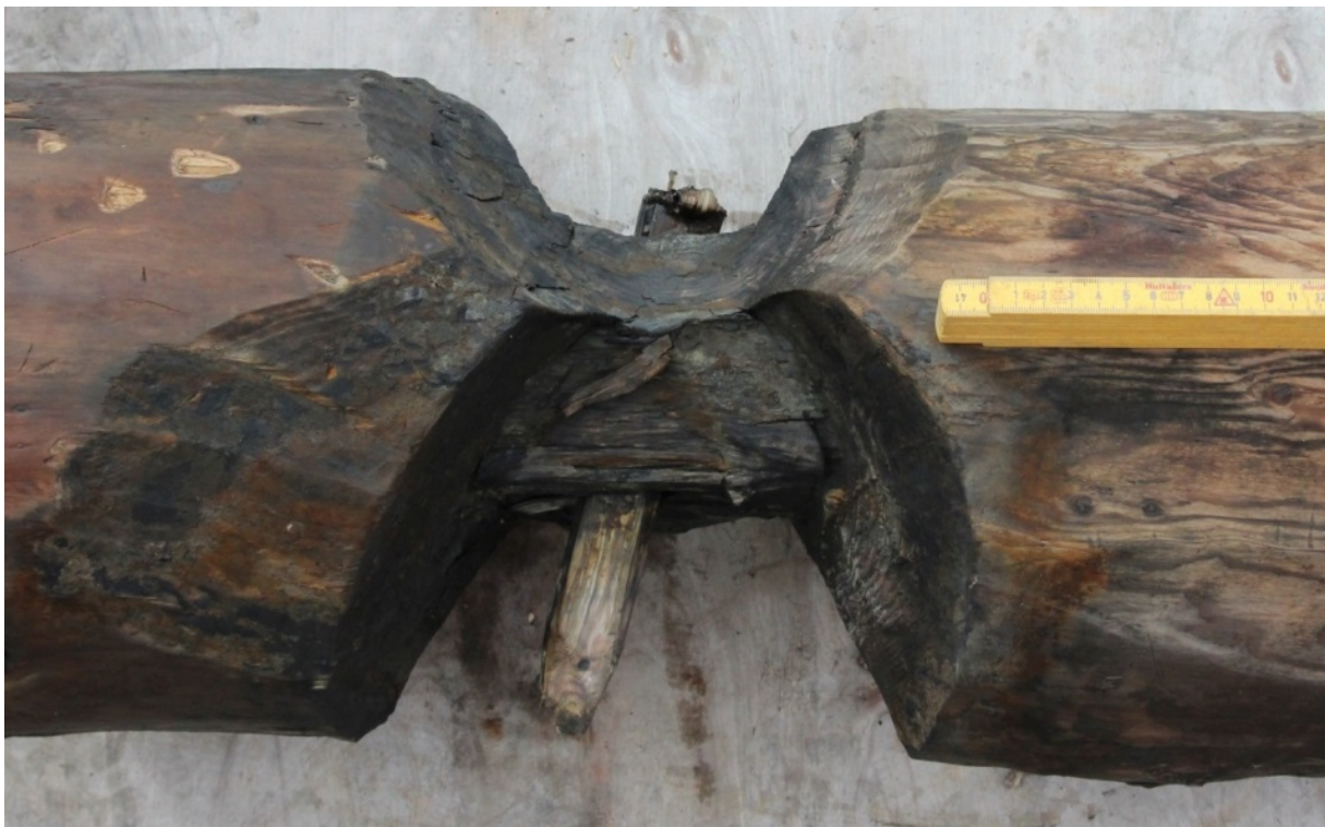
Figur 43: niku_ark_335239. Bunnstokk fra K209 med Raulandslaft og dymling.
