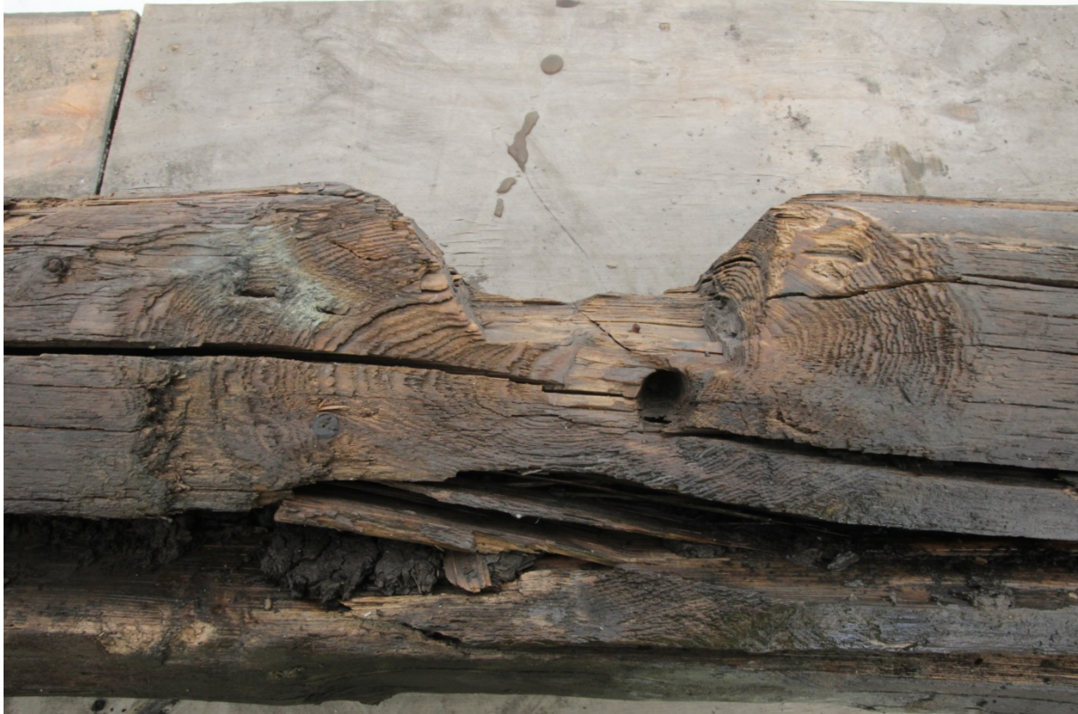
Figur 45: niku_ark_335120. Hull i laftehugg tilhørende en av stukkene i K209.
