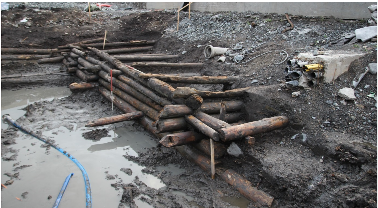
Figur 50: niku_ark_333423. Østre vegg av laftekasse K210. Legg merke til de utstikkende stikkene, noen med slepehull, samt styringspinnen som stikker opp fra innsiden av kassens nordøstre hjørne. Foto mot sør.
