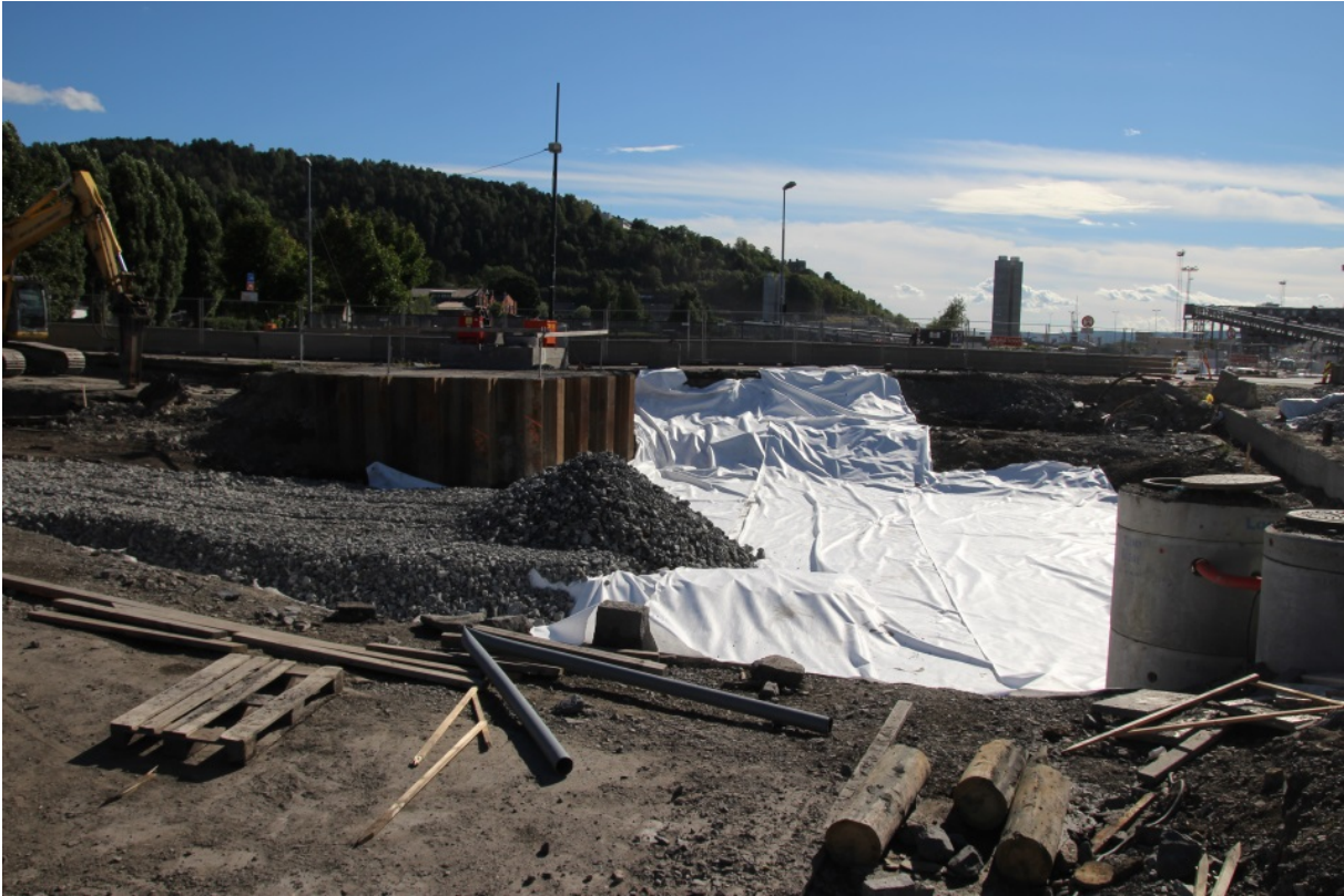
Figur 41: niku_ark_335395. 3 september 2013 ble «Nordenga» gjengravd. Påføring av pukk over veiduk.
