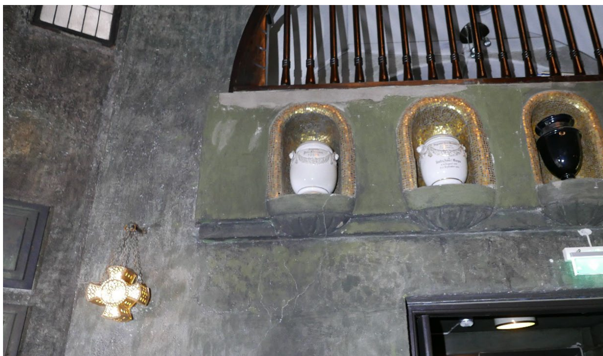
Figur 27 Foto tatt mot felt fire i hovedrommet. I bildet sees sprekker i veggen og skjemmende reparasjoner i området rundt urnene. Malingen virker matt og dekkende i forhold til resten.
