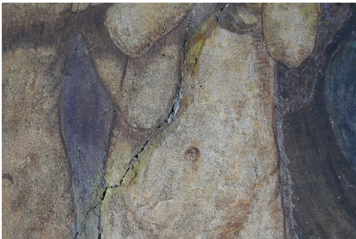
Figur 18 En sprekk i muralmaleriet i nisjen bak katafalken. Denne er tidligere reparert (uvisst når), men pigmentene er misfargede og reparasjonsmaterialet delvis manglende.
