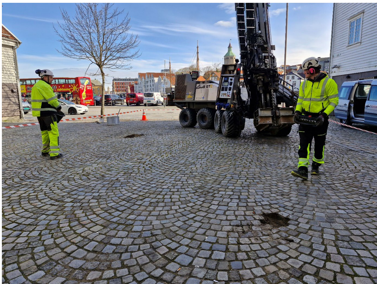
Figur 4. Helmich Gabrielsens plass, boring av punkt KS03. Punktene KS02 og KS01 ses i bakgrunnen. Foto mot nordøst.
