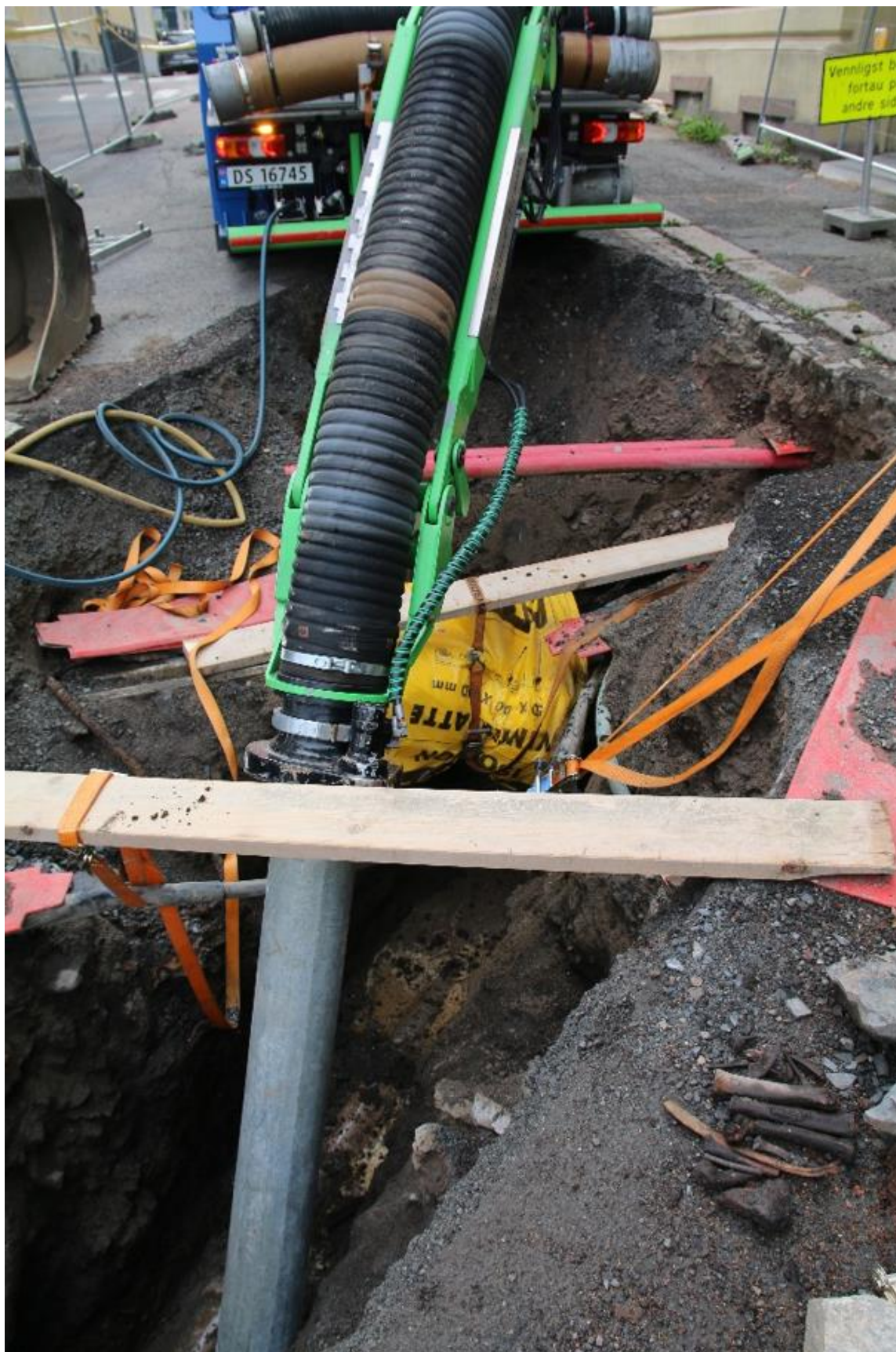
Figur 3: Det ble tatt i bruk sugebil (vakuumgraver) for å få gjennomført tiltaket pga. antall ledninger på tvers av grøften. Sett mot øst. Foto: Cf55622_NIKU_06.
