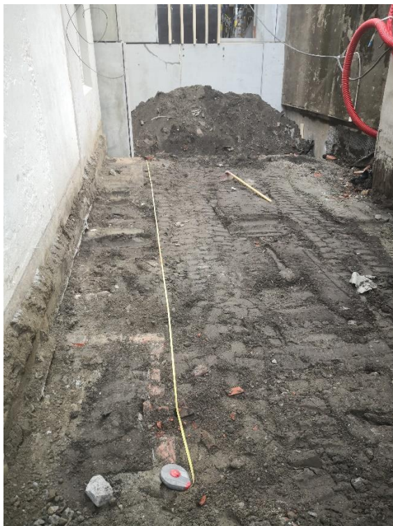
Figur 7: Tiltaksområdet etter fjerning av asfaltdekke og grus. Sett mot øst. Målebåndet viser ca. 9 m. Til venstre ses to lysgraver til eksisterende bygg i Thomas Angells gate 7. Lengst øst i bildet ses nybygg tilknyttet Nye Hjorten teater i Dronningens gate 10. Til høyre i bildet ses bygningsmasse tilhørende Dronningens gate 12.
