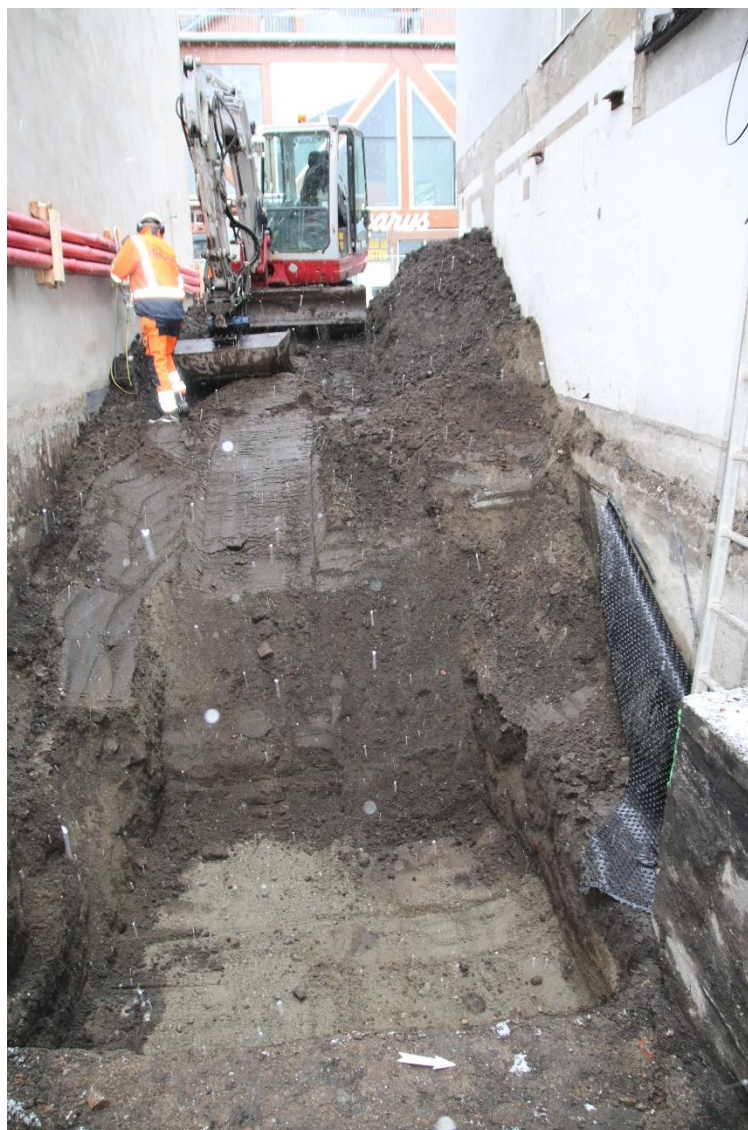
Figur 5: Illustrasjon av arbeidsforholdene på stedet. Området som skulle totalgraves er gravd i bunn, og den lyse undergrunnen synes tydelig mot de mørke kulturlagene i graveskråningen. Foto er tatt mot vest, og den vestlige graveskråningen var ca. 3,5–4 m høy. Maskinfører Snorre Moe ses til venstre i bildet. Foto: NIKU.
