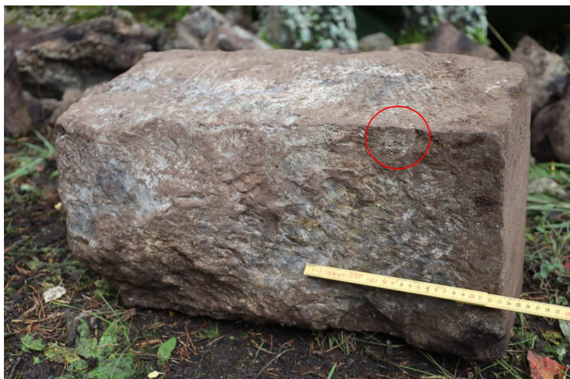
Figur 11: Halve byggsiden er grovt tuktet mens den andre er fint tuktet. Dette kan ha vært gjort for å tilpasse steinen til forbandet i et hjørne. På kanten sees også et fint tilhugget kilehull fra steinbryting eller kløyving. Foto-nr: Cf55630_NIKU_0009.
