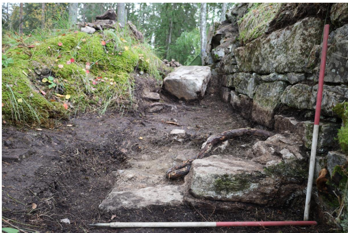
Figur 19: Sett mot sør: 2–3 skift i murskallet var godt bevart. Det øverste skiftet besto imidlertid av mindre steiner/pinningsteiner. I bakgrunnen sees den store steinen som raste ut av østmuren i 2020 (note 23). Foto-nr: Cf55630_NIKU_0017.
