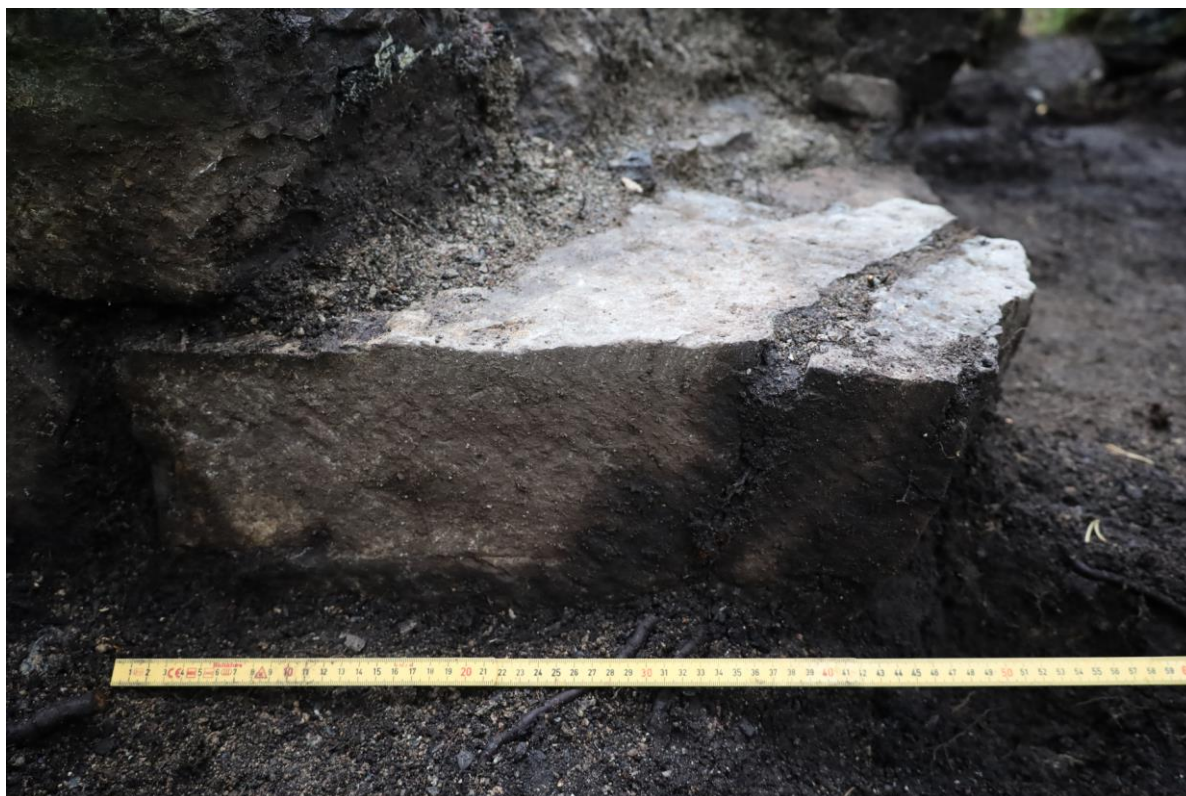
Figur 14: Sett mot nord: Kvadersteinens visside med spor av diagonalhugging og definert randslag. Steinen har en sprekk på tvers, og ytterste del mangel. Foto-nr: Cf55630_NIKU_0012.
