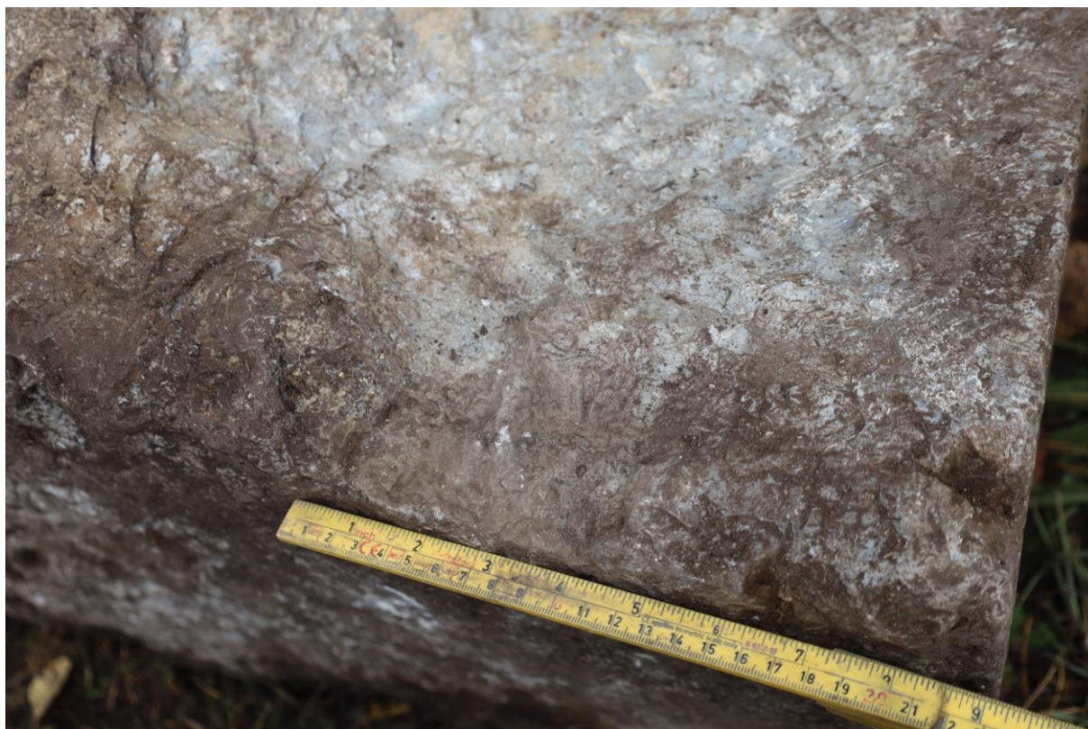
Figur 12: Kilehull i kvadersteinen. Foto-nr: Cf55630_NIKU_0010.
