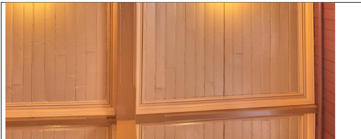
Utsnitt av foto av himling. Det er nærliggende å tro at himlingen har vært malt hvitt (lag 1), mens drager, bjelker, listverk og stolper har vært ådret som ådring på drager. Foto. b+b arkitekter as
