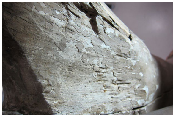
Testfelt bak på skulder, før konsolidering med LMK:vann 1:1
