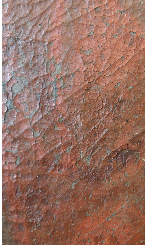
Figur 12. Område der malingen har skallet av og grunderingen er synlig. Slike tap ble retusjert, men ikke kittet.
