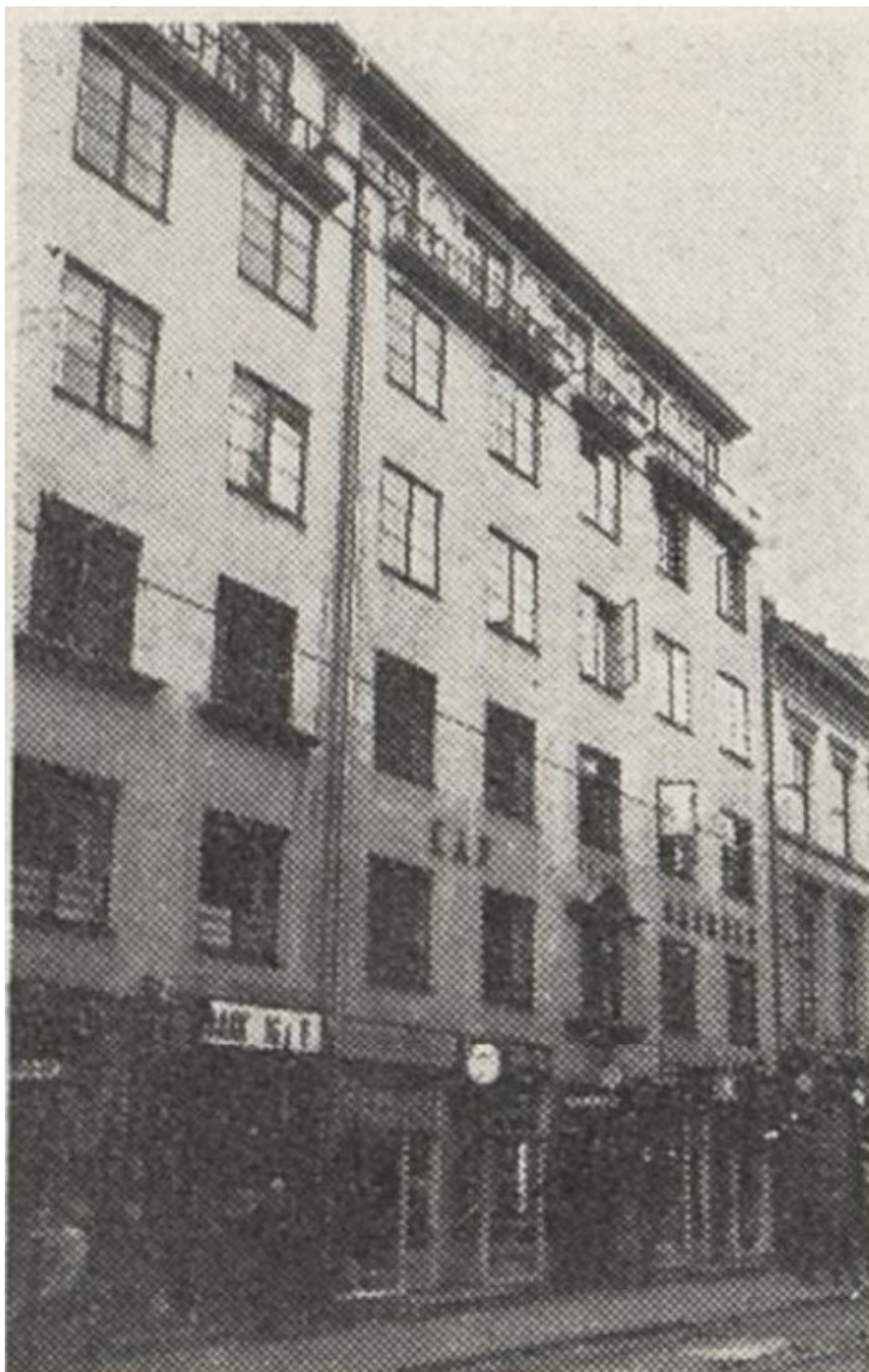
Figur 37 Ca. 1946. Foto: Hofflund og Nyquist. 13 De murte vannbrettene under vinduene i 3. etasje er fjernet på fasaden til nr. 23.
