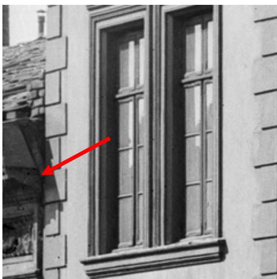
Figur 28 Uten datering. Opprinnelig konsoll markert med rød pil. Utsnitt av foto i figur 7.
