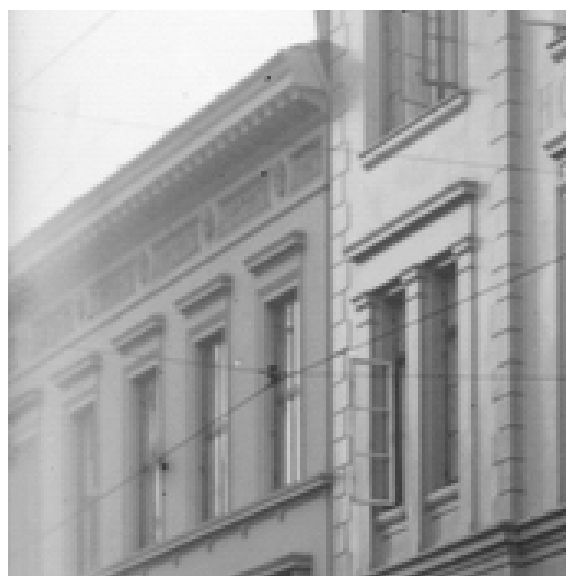
Figur 29 ca. 1910. Her ser man tydelig den opprinnelige takgesimsen. Utsnitt av foto i figur 6 og 27.
