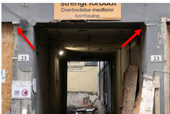
Figur 48 Opprinnelig avslutning av sokkeletasjen mot fasaden over. Røde piler viser hvor profilen er bevart. Foto: NIKU, 2024.
