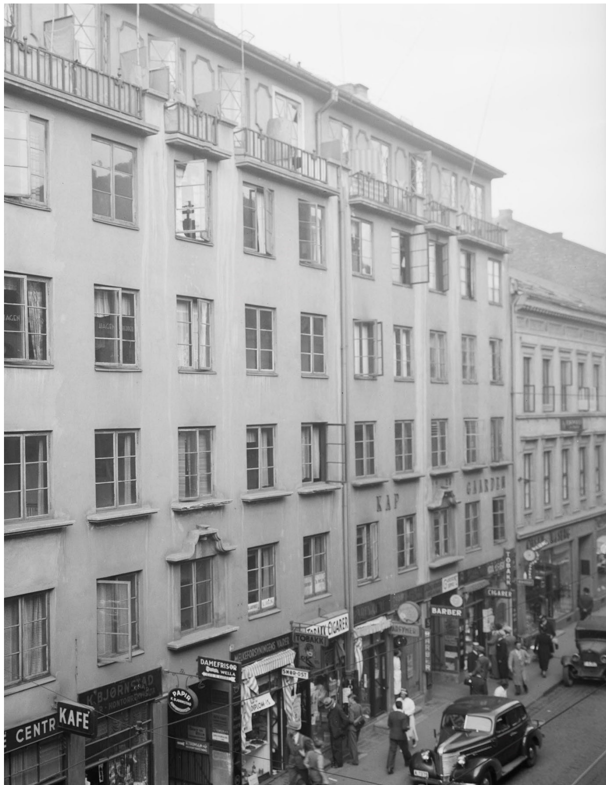
Figur 36 1930-1937. Foto: ukjent (utsnitt). 12 Murte vannbrett under vinduene i 3. etasje.
