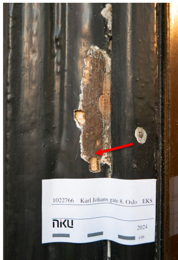
Figur 22 Avdekking av første malingslag på vindusrammen. Markering av opprinnelig brunfarge med rød pil. Foto: NIKU, 2024.
