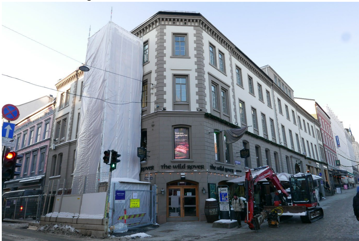
Figur 1 2024. Karl Johans gate 8. Fasade mot Dronningens gate i sørøst og Karl Johans gate i nordøst. Foto: NIKU, 2024.
