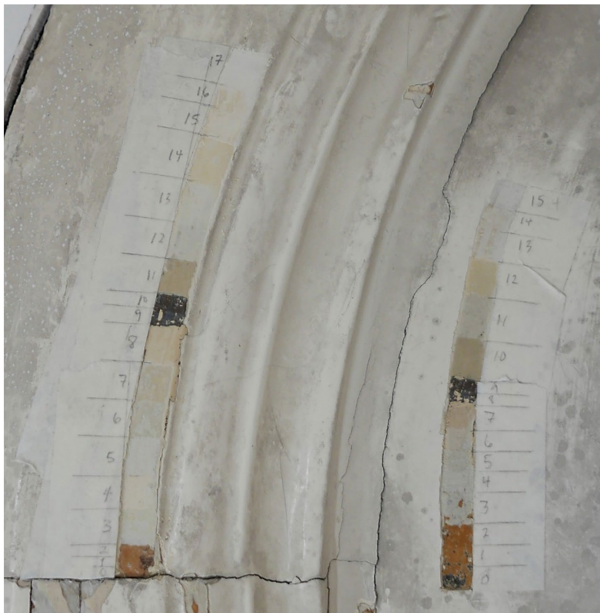
Figur 14 Avdekking VB23 Gerikt og overstykke.
