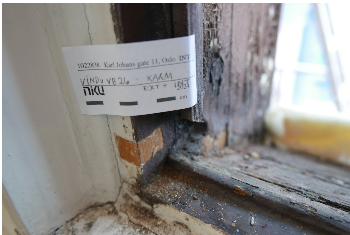
Figur 25 VB26. Avdekking av innerste lag i overgang inne og ute på karm.
