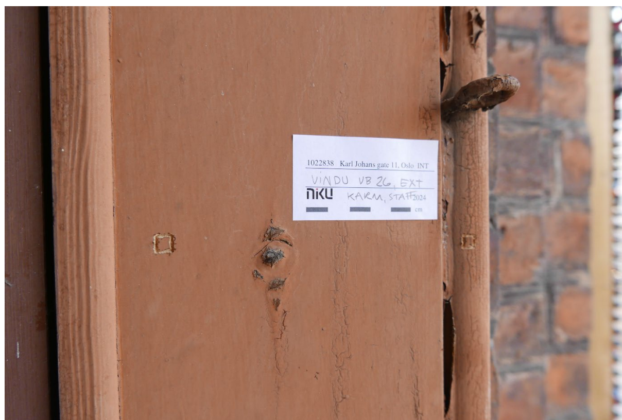
Figur 24 VB23. Eksteriør karm og staff. Uttaksted materialprøver.
