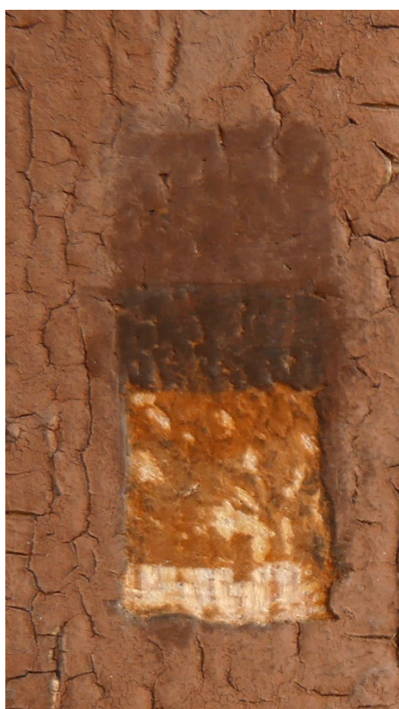
Figur 25 VB26. Avdekking av innerste lag i overgang inne og ute på karm.
