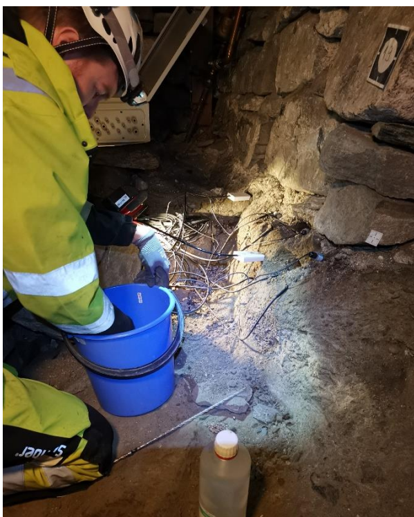
Figur 34: Installasjon av sensorer ved miljøprofil 1. Foto: Cautus Geo AS.
