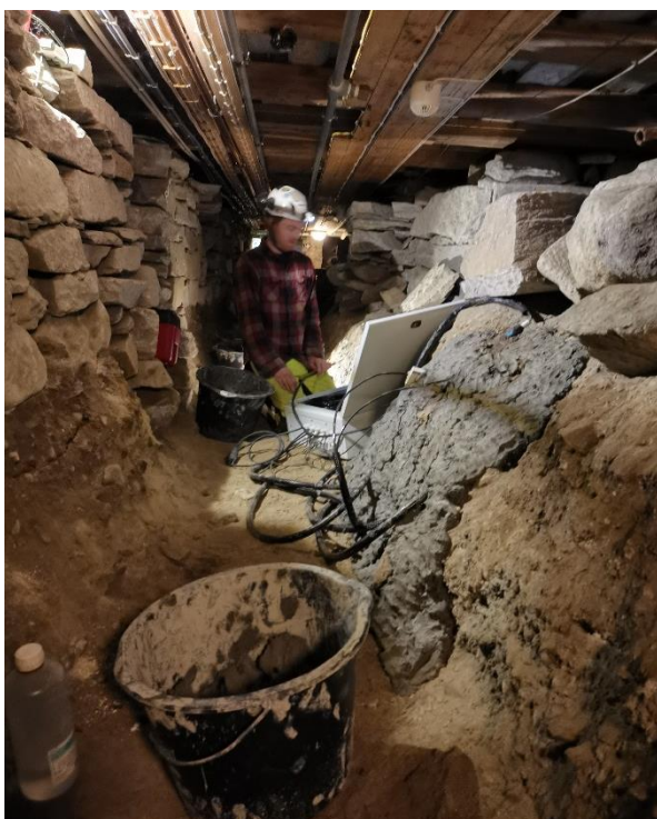
Figur 38: Tildekte sensorer ved miljøprofil 2. Foto: Cautus Geo AS.
