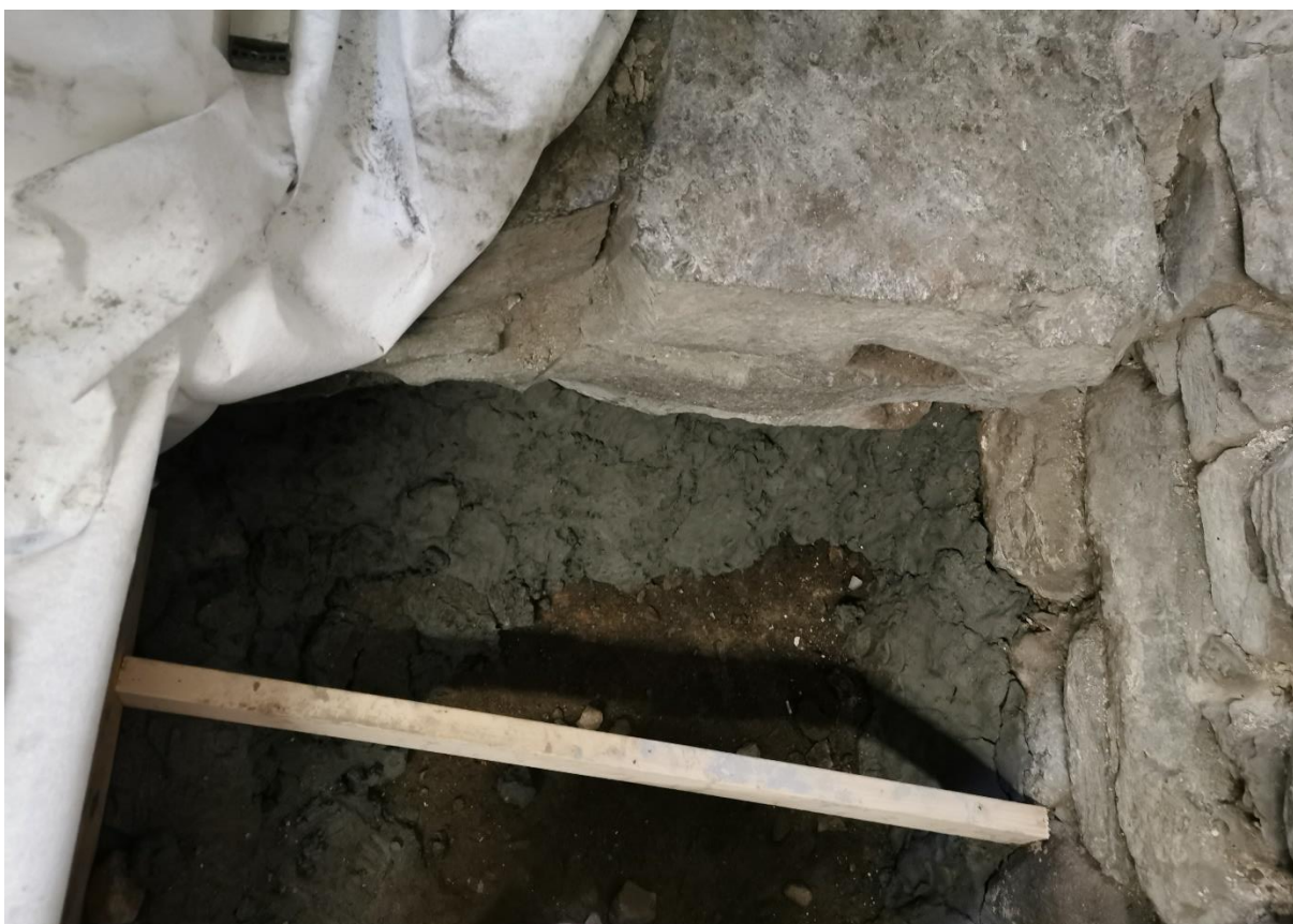
Figur 14: Miljøprofil 3 tildekket med leire etter ferdigstilt installasjon. Sett mot nordvest. Foto: Sf223947.
