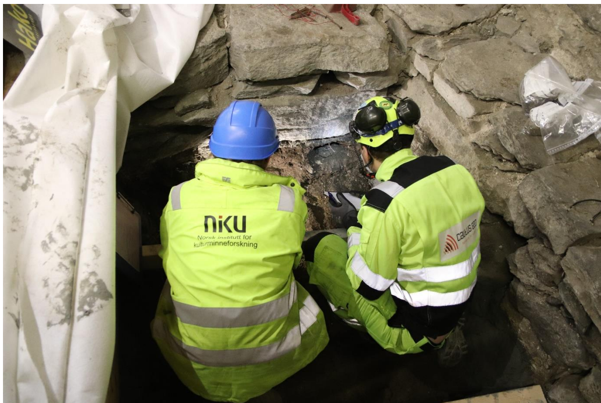
Figur 12: Miljøprofil 3 under installasjon av sensorer i kammer A2. Sett mot sør. Foto: Sf223946
