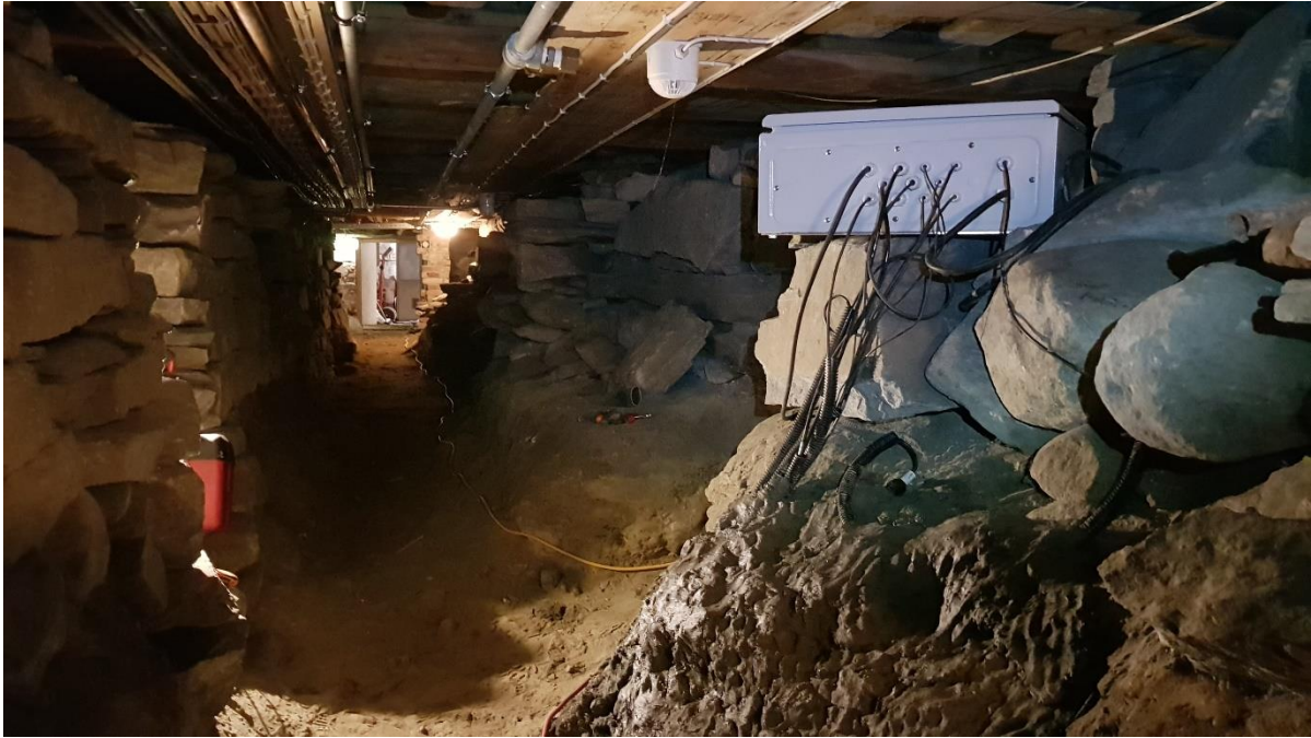
Figur 41: Ferdig installasjon miljøprofil 2. Foto: Cautus Geo AS.
