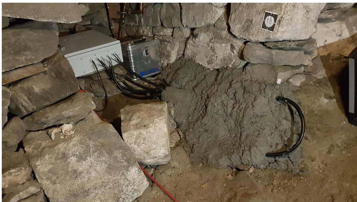
Figur 40: Ferdig installasjon miljøprofil 1. Foto: Cautus Geo AS.
