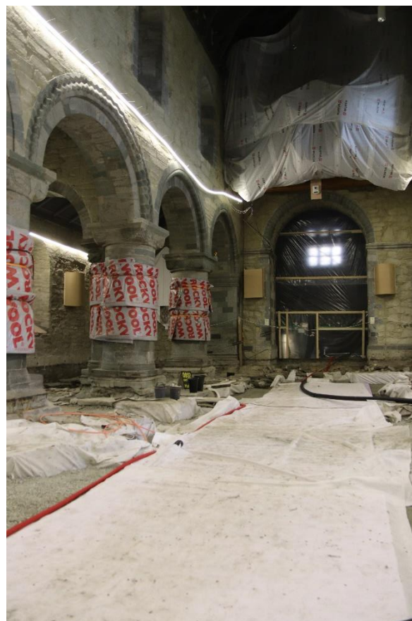
Figur 23: Tv.: Kabler fra sensorer legges i plastrør fra miljøprofil 4 og ut i midtgangen. Sett mot nord. Foto: Sf210366. Th.: Plastrør med kabler fra sensorer fra miljøprofil 4 er lagt i rødt føringsrør frem mot «teknisk rom». Sett mot vest. Foto: Sf210430.
