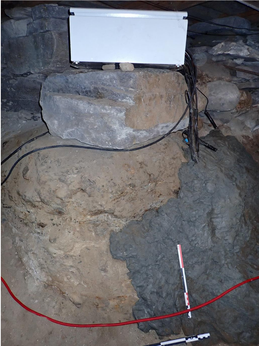
Figur 9: Miljøprofil 2 tildekket med leire etter ferdigstilt installasjon. Skap for datalogger ble plassert like over profilet fram til den skulle flyttes til «teknisk rom». Sett mot sørvest. Foto: Sf223956.
