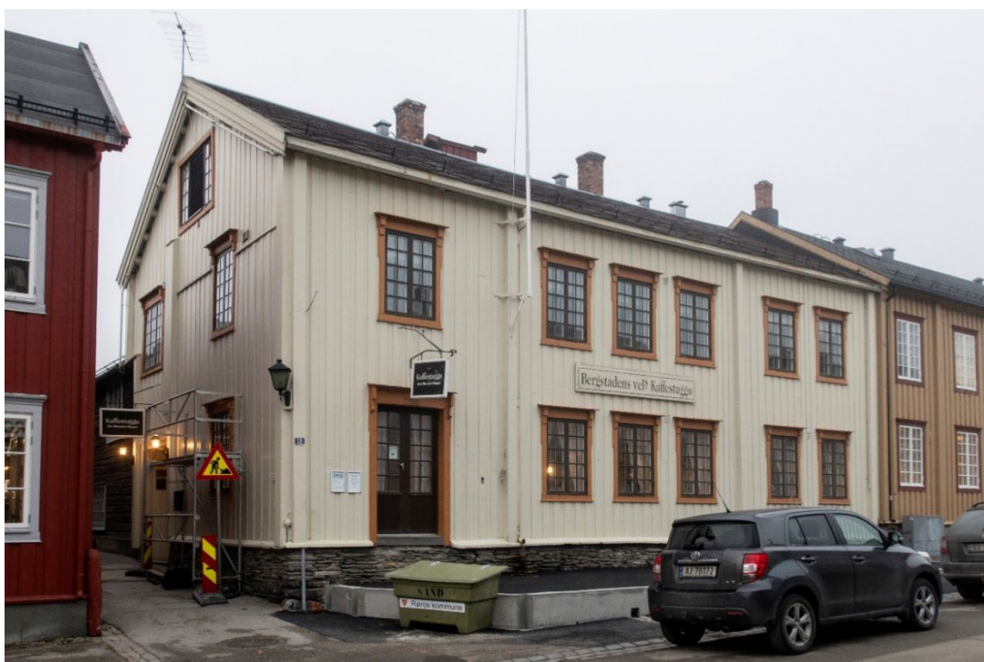
Figur 1 Fasade mot Bergmannsgata og gavlvegg mot veita til Kjerkgata. Foto: NIKU, 15.11.2022.
