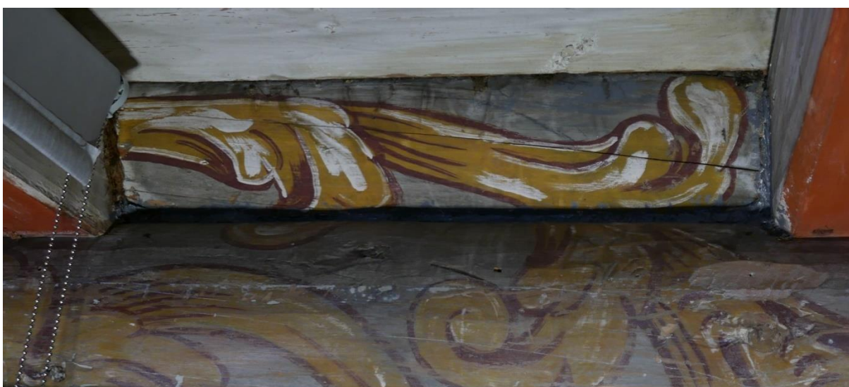
Figur 3 Eksempel på avdekket limfargedekor på vegg. Øvre del av lafteveggen ble dekket av himlingsbord i 1882. Samtidig ble veggene nedenfor malt over med ensfarget hvit oljemaling. Man kan se skillet mellom den godt bevarte dekormalingen på den øvre laftestokken i bildet og den mer slitte dekoren, som ble overmalt og deretter avdekket, på nedre stokk. Malingen ble fjernet og dekoren tatt frem igjen på 1950-tallet. Selv om mye av dekoren på veggene er bevart er det som kan vi se at mye av fargenes intensitet og kontraster er borte. Det hvite høylyset er gått tapt. Foto: Wedvik/NIKU, 2019.
