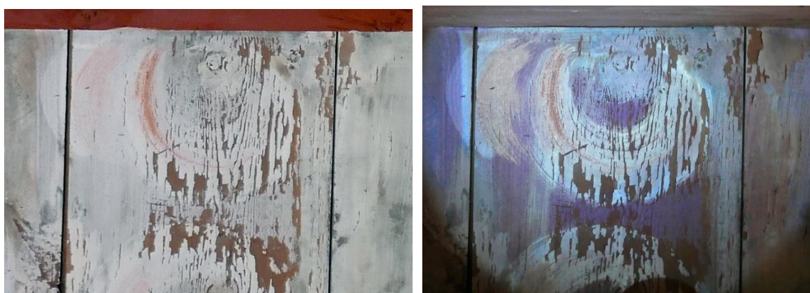
Figur 24 Område på galleriet med skadet og tidligere retusjert limfarge. a) Pålys b) UV-opptak. UV-opptaket viser omfattende retusjering. Foto: Wedvik/NIKU 2021/2020.
