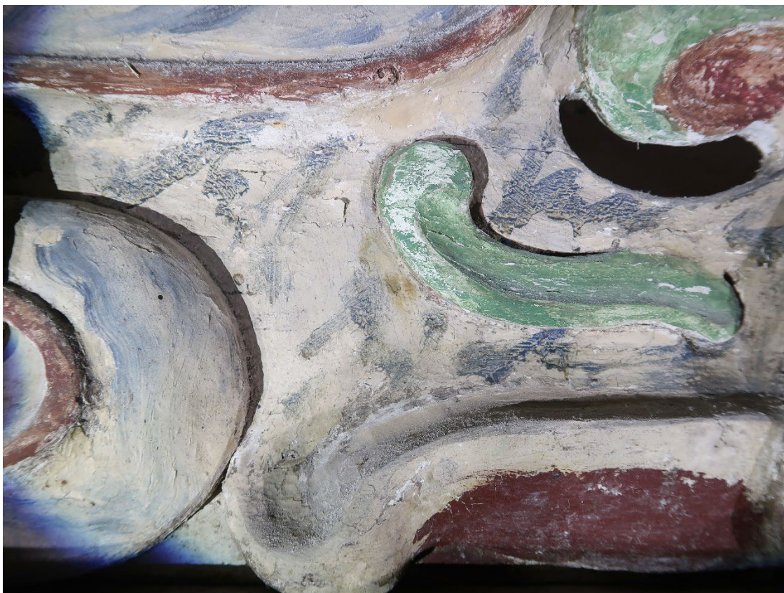
Figur 20 Oppskallende maling på lys marmorering med blå årer.
