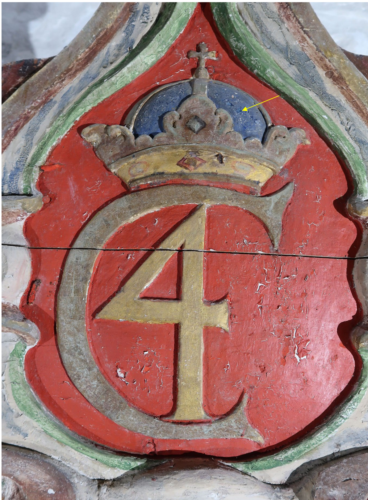
Figur 22 Rødmaling har krympet og skaller opp. Blå maling (gul pil) har blitt retusjert ved en tidligere konservering.
