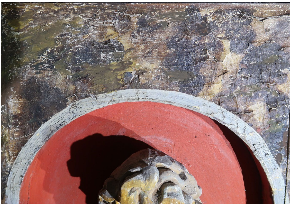
Figur 18 Brun marmorering har mye oppskallet maling. Ved en tidligere behandling har skadene blitt retusjert. Retusjene er matte og i dag misfargete.
