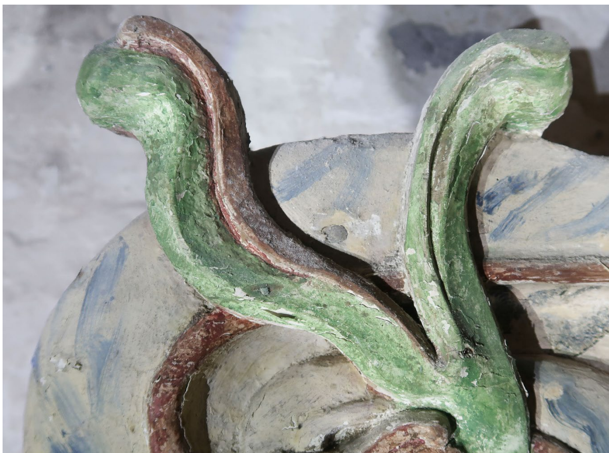
Figur 17 Lys grønnmaling har mye oppskallinger. Malingslaget er tynt.
