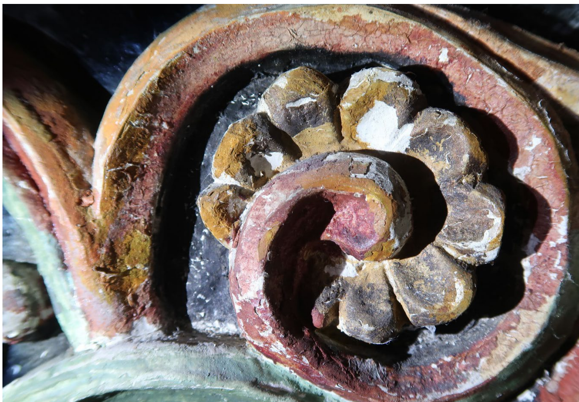
Figur 33 Testfelt 4 etter festing av maling med LMK/vann 1:1.
