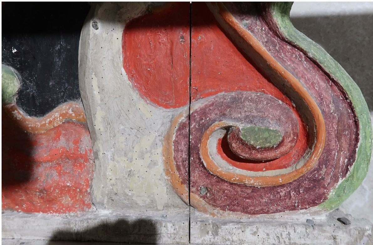
Figur 16 Hvit maling har skader som ved en tidligere behandling er blitt retusjert.
