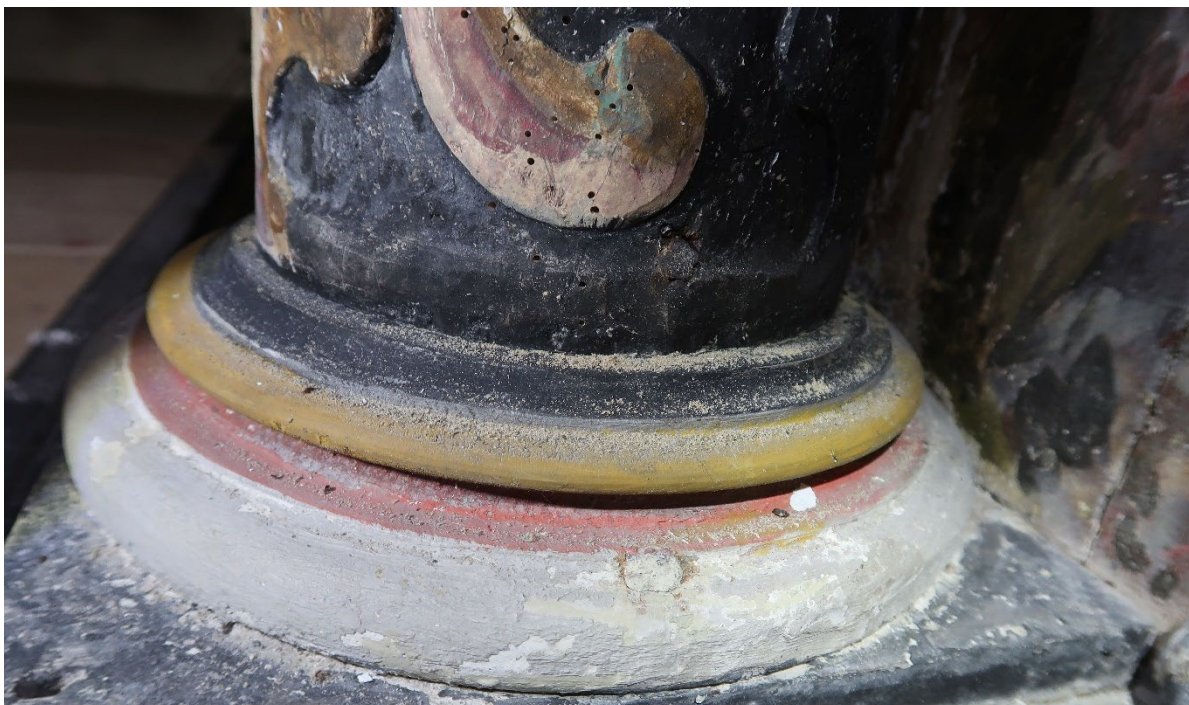
Figur 13 Opphopning av tremel på høyre søylebase. Borehull etter borebiller er synlig på søyleskaft.
