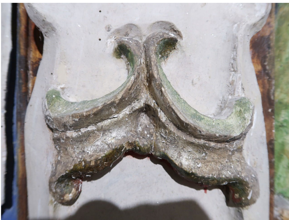
Figur 21 Oppskallende maling på forgylt flate.
