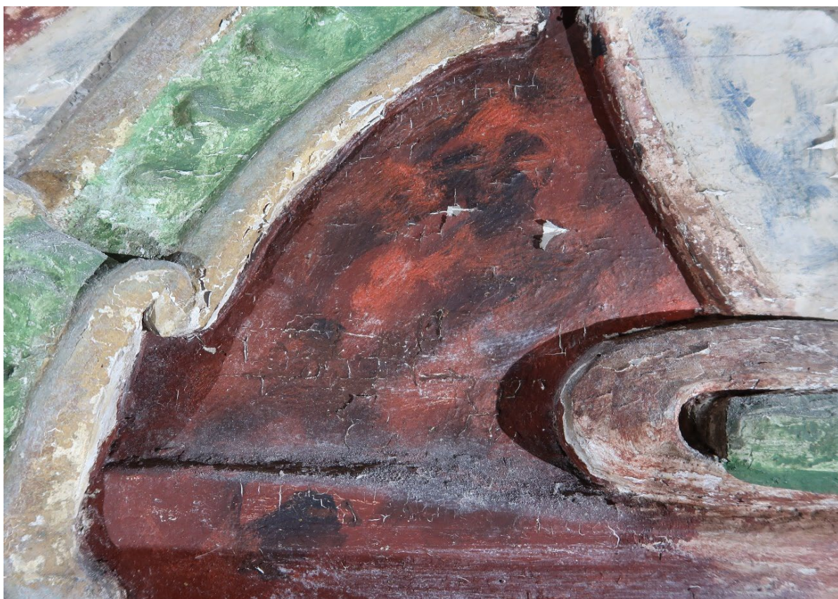
Figur 19 Rød marmorering har en del oppskallinger.
