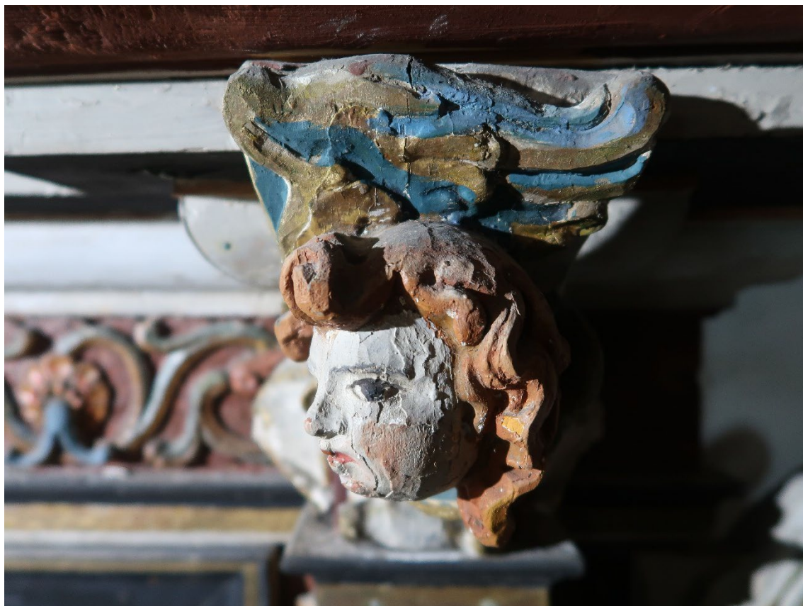
Figur 46 Detalj englehode over søylene kapiteler. Her er det mange gamle retusjer/overmalinger og nye oppskallinger.
