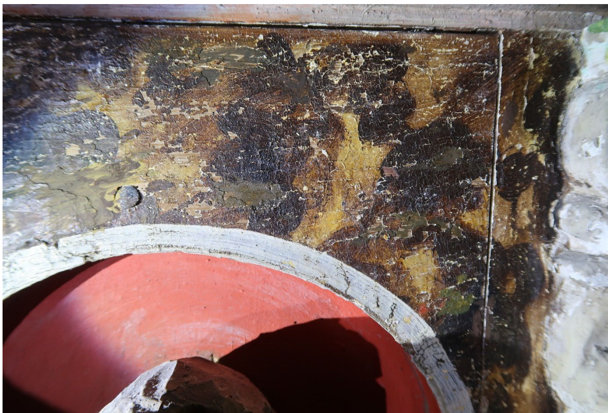
Figur 37 Testfelt 6 etter festing av maling med MC etterfulgt av ren LMK.
