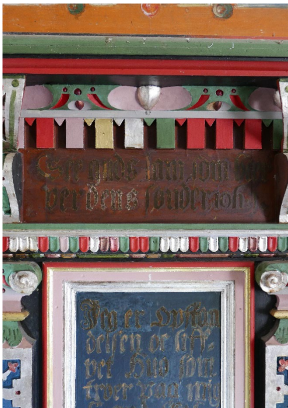
Figur 14 Detalj av høyre fløydørs innside. På øvre skriffelt er bunnfargen ikke overmalt. Skriften er delvis slitt og trolig oksidert og av den grunn vanskelig å lese på den brune bunnen. NIKU ICL
