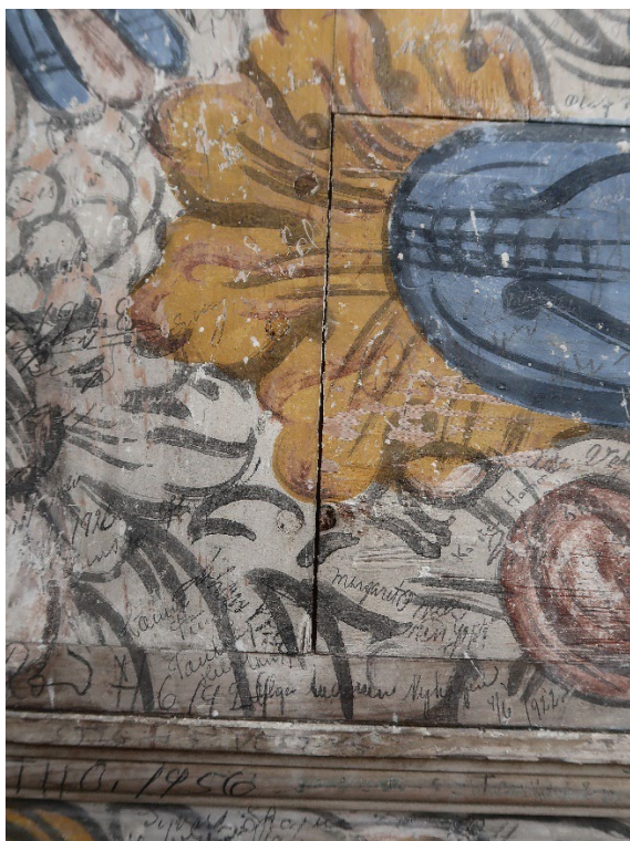
Figur 16 Detalj av bakside av korpus. Det er mye tagging på dekoren. Det er slitasjeskader og noen avskallinger og oppskallinger.
