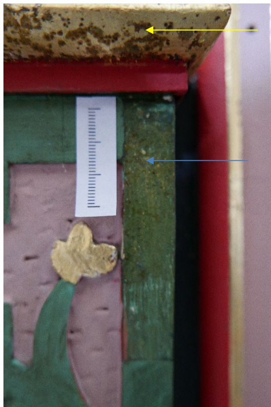
Figur 13 Detalj av lisene på høyre fløydøren innside. Et tittehull etter restaureringen i 1976-79 viser original maling (blå pil). Mørke flekker på gull (gul pil). NIKU ICL
