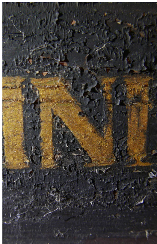
Figur 15 Detalj av høyre fløydørens innside. På nedre skriffelt skaller det opp maling. I oppskallingen kan det skimtes en brun bunnfarge. NIKU ICL
