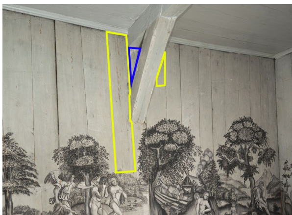
Fig. 42. Markering av område der det ble gjort flatekonsolideringstester med metylcellulose (gul markering) og størlim (blå markering).
