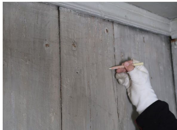
Fig. 60. Detalj av øvre del av nordvegg underveis i den visuelle reintegreringen av avskallinger ned til treverk og skjolder.
