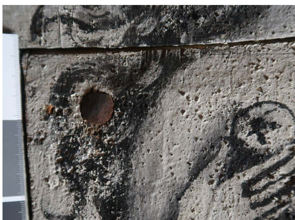
Fig. 28. Detalj av spiker og skjøt mellom paneler.
