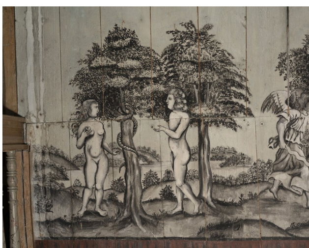
Syndefallet på nordveggen. Før behandling.
