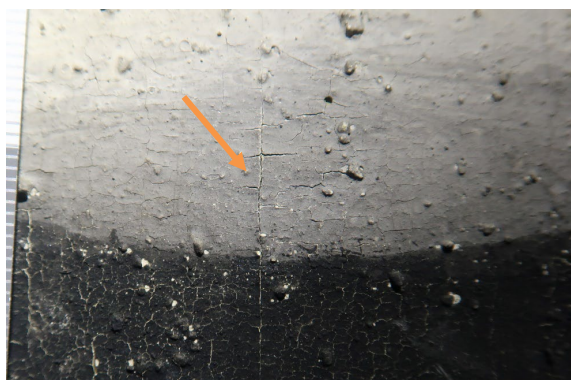
Fig. 51. Detalj av løse farger og lukkede oppskallinger etter konsolidering.
