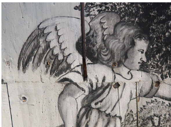
Fig. 10. Detalj av skjøter mellom panelene i figurscenene, festet med håndsmidde metallspiker. Nordvegg.
