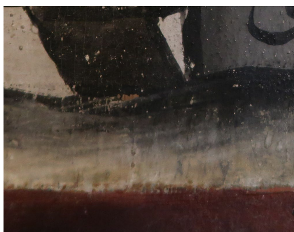
Fig. 35. Detalj av fukt og slitasjeskader på nedre del av motivet av Paktens ark i overgangen til brystningen.
