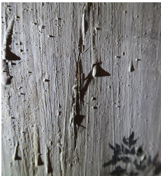
Fig. 15. Detalj i sidelys av klumpete renn fra grunderingen, dekket med original hvit maling og blågrå overmaling i himmelpartiet. Nordvegg.
