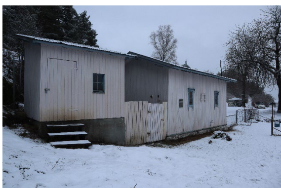
Ishuset til venstre, uthuset til høyre. Foto fra NV.
