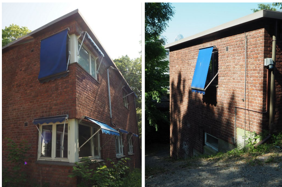
Figur 3-8 Entrepertiet ved Halvor Blinderens plass. Panelt konstruksjon er sekundær; her var tidligere et åpent parti under skjermtaket.
