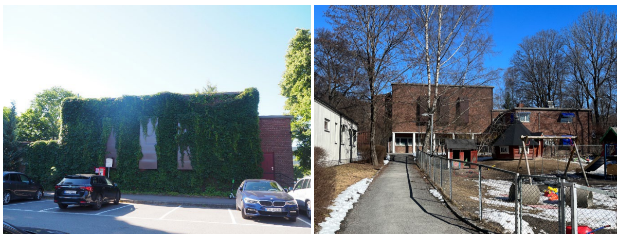
Figur 3-5 Fasadene sett fra nordøst og sørvest.
