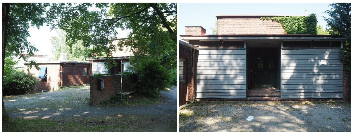
Figur 3-8 Entrepertiet ved Halvor Blinderens plass. Panelt konstruksjon er sekundær; her var tidligere et åpent parti under skjermtaket.
