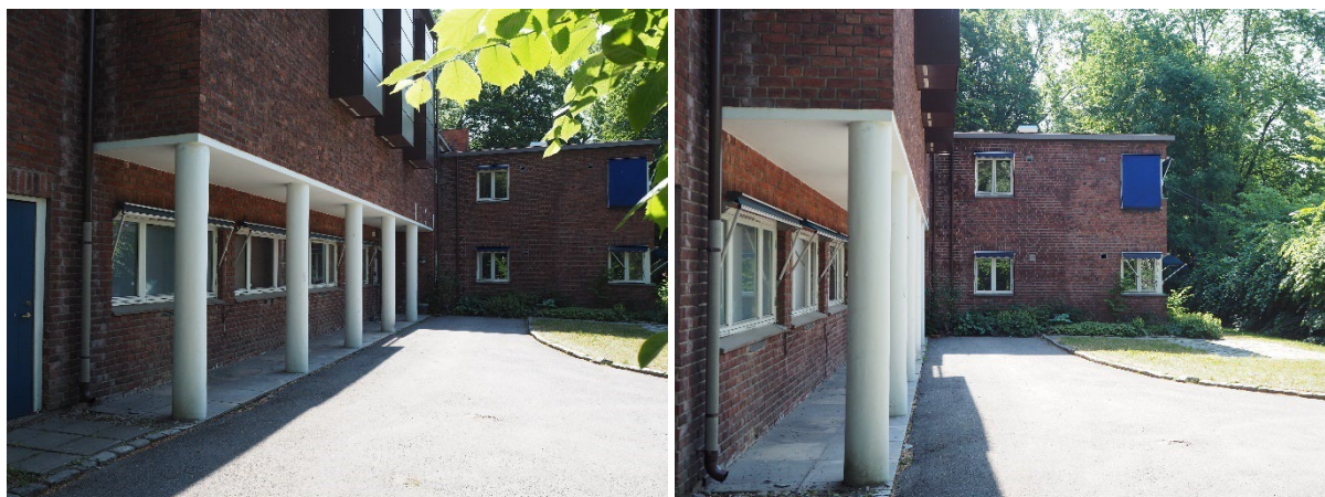
Figur 3-7 Fasader mot sørvest med de karakteristiske og tidstypiske hvite søylene. De to hovedvolumene danner et noe avskjermet gårdsrom. I indre hjørne er det adkomst til trapperommet. Døren til venstre i bildet er satt inn senere, jf. eldre tegninger.
