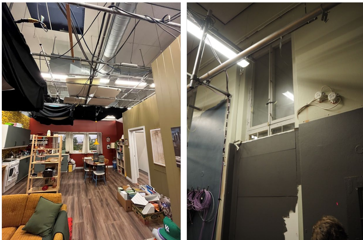
Figur 3-4 Den store salen i øvre etasje brukes som studio. Himlingen er nedforet med akustikkplater. De høye vinduene er alle bevart.
