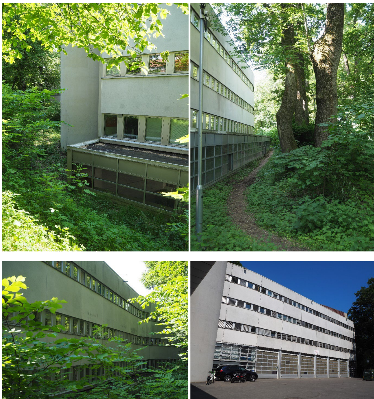
Figur 2-11 Fasadene med vindusbånd og plater av kunststein. Nedre etasje med garasjer er dypere enn øvre etasjer.
