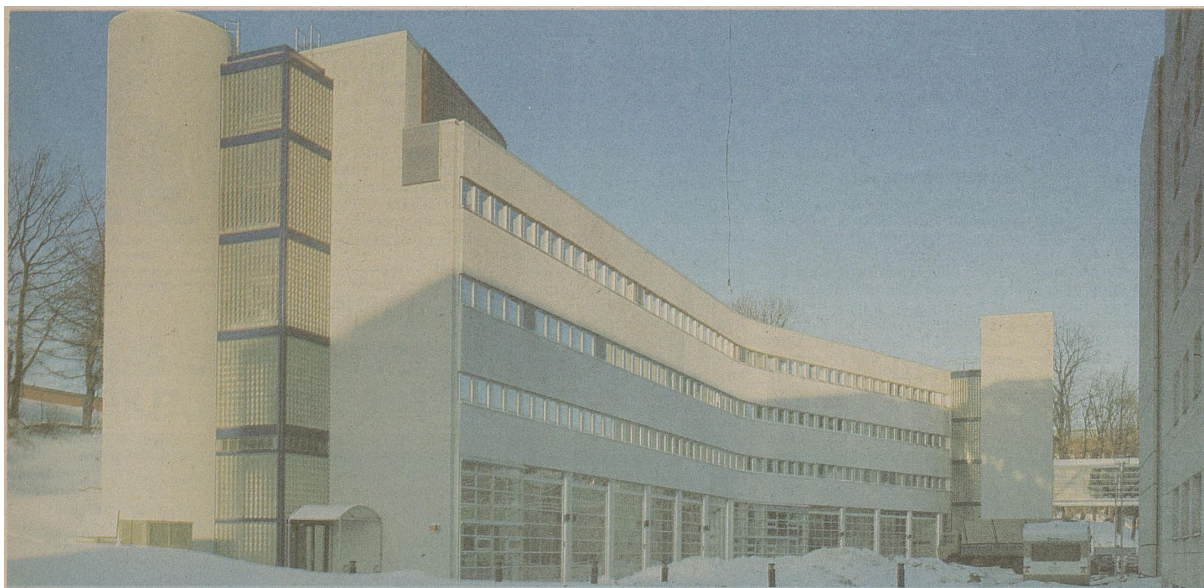
Figur 2-4 G-fløyen sett fra vest. Kilde: Byggenytt 1984
