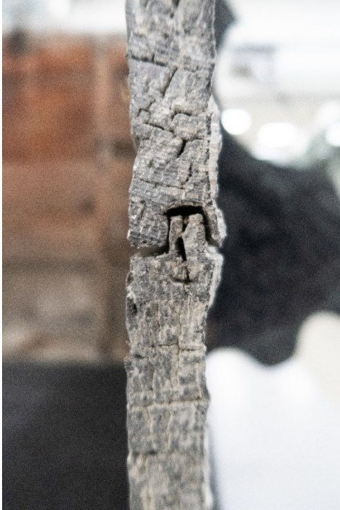
Figur 3 Not og fjær på øvre og midtre bord på sørvendt flate. Slitt framside (mot høyre). Foto: NIKU, Hulda Blix, 2020
