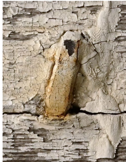
Figur 39 Rustflekker etter rensing. Foto: MUHO Heleen van Santen
