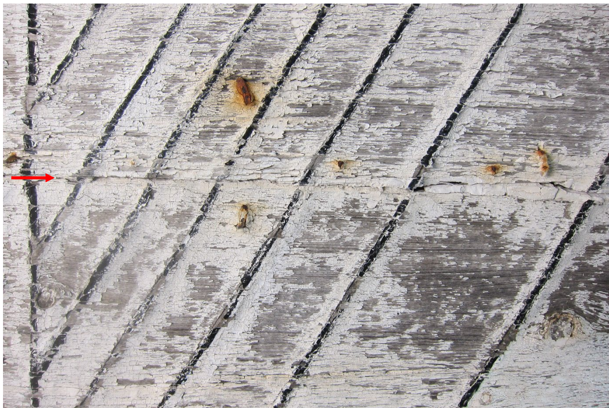
Figur 31 Området på østvendt flate før (øvre del) og etter (nedre del) festing av maling. Foto: NIKU Christina Spaarschuh, 2022
