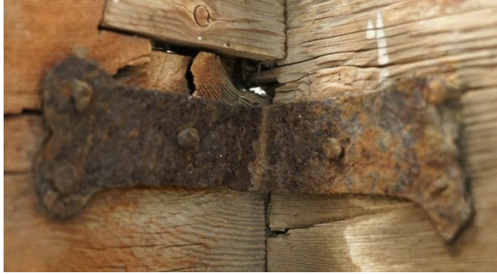
Figur 19 Øverste vinkeljernet før behandling. Foto: MUHO Heleen van Santen
