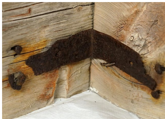
Figur 26 Nederste vinkeljern etter konsolidering, støtting med japanpapir og plassering i riktig posisjon. MUHO Heleen van Santen
