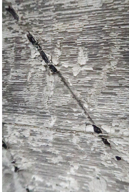
Figur 4 Løs og delvis manglende maling på framsiden av soluret. Foto: NIKU, Hulda Blix, 2020
