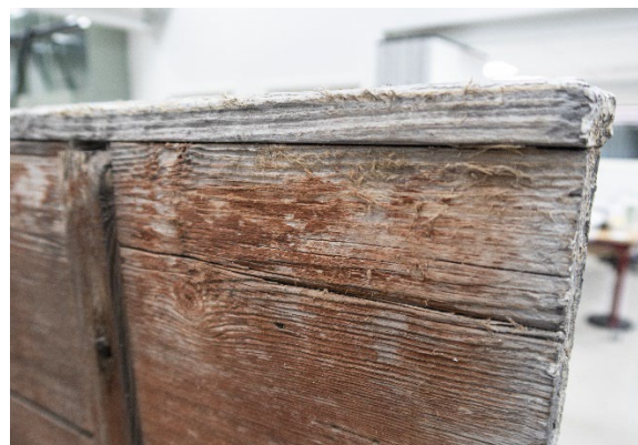
Figur 8 Oppfliset overflate på øvre del av sørvendte flate. Foto: NIKU, Hulda Blix, 2020.
