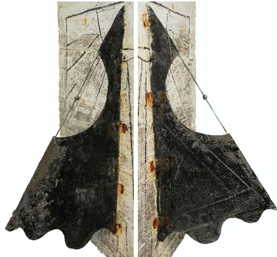
Figur 37 Sørvendt gnomon etter konsolidering av maling og strukturell konsolidering av vinkeljernet. Foto: MUHO Heleen van Santen
