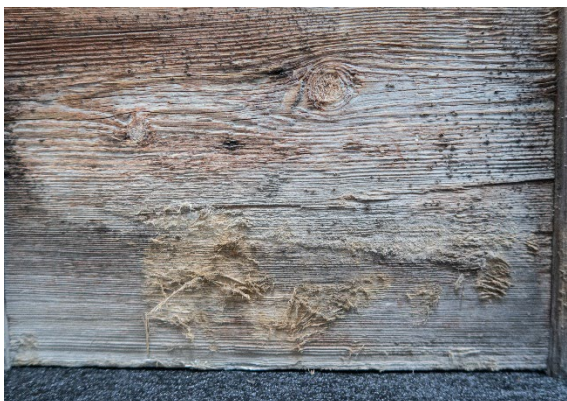
Figur 7 Oppfliset overflate på nedre del av sørvendte flate. Foto: NIKU, Hulda Blix, 2020.
