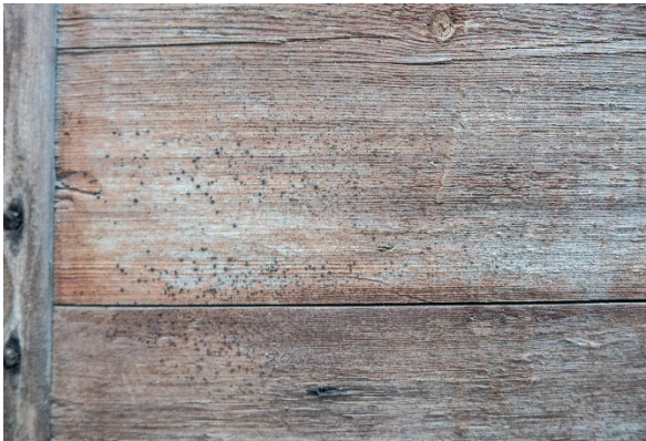
Figur 6 Svertesopp på baksiden av sørvendte flate. Foto: NIKU, Hulda Blix, 2020
