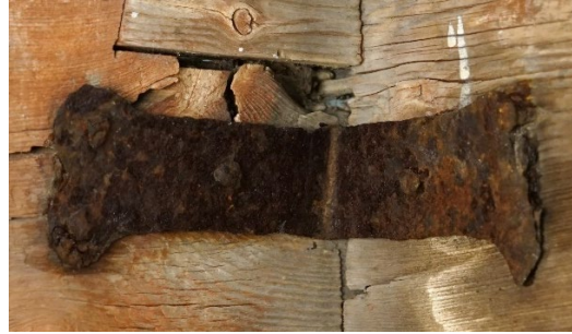
Figur 20 Øverste vinkeljernet etter konsolidering og plassering av en foring med japanpapir. Foto: MUHO Heleen van Santen
