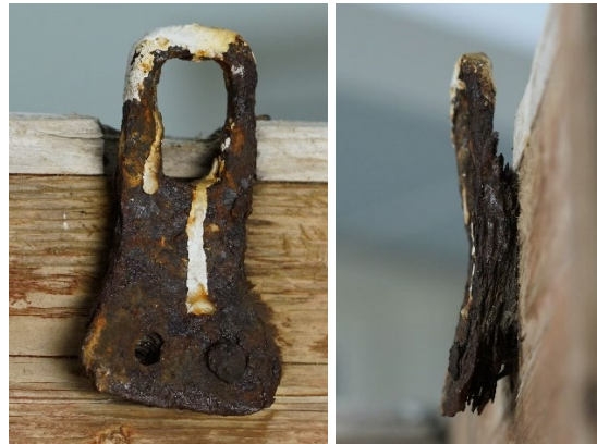
Figur 22 Metallhempe på østvendt flate etter behandling. Foto: MUHO Heleen van Santen
