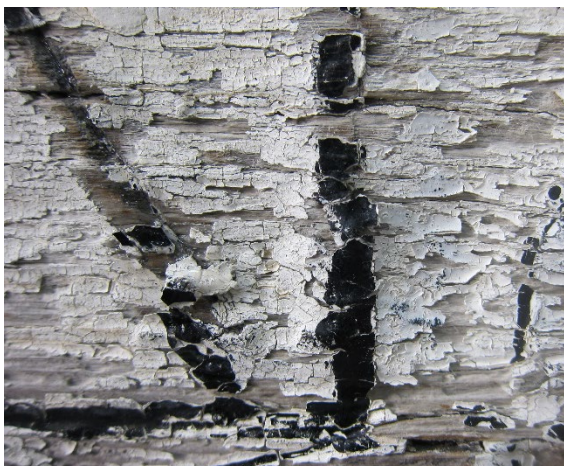
Figur 9 På forsiden sitter malingen løst. I strekene ligger det tykke lag med maling, mens i flaten imellom ligger ofte den hvite malingen tynt. Foto: NIKU, Christina Spaarschuh, 2022
