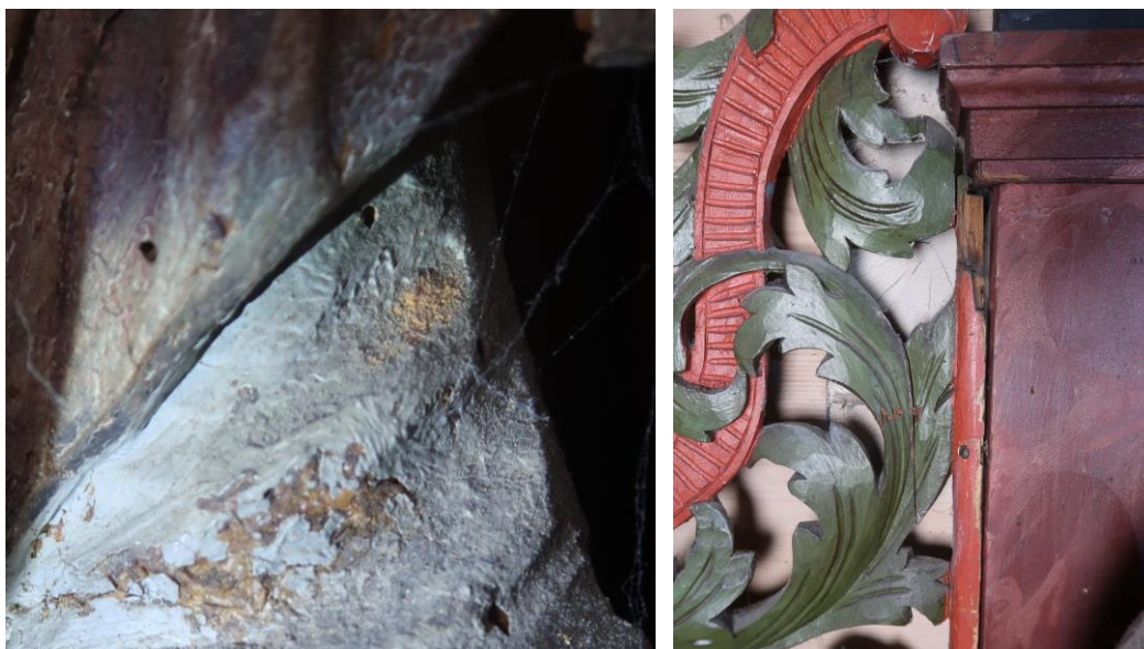
Figur 16 a,b Skader i trekonstruksjon a) Ansamling av bille-mel b) Venstre vinge er dårlig festet og listen mangler biter.
