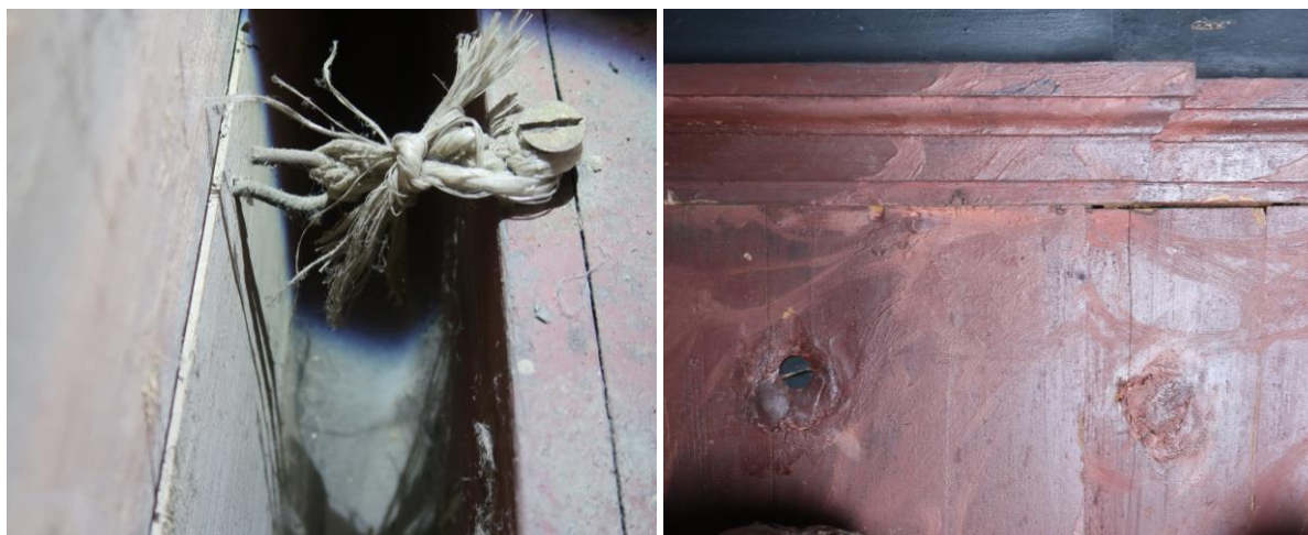
Fig 5a,b) Oppheng: a)Plasttau og b) flate sporskruer.
