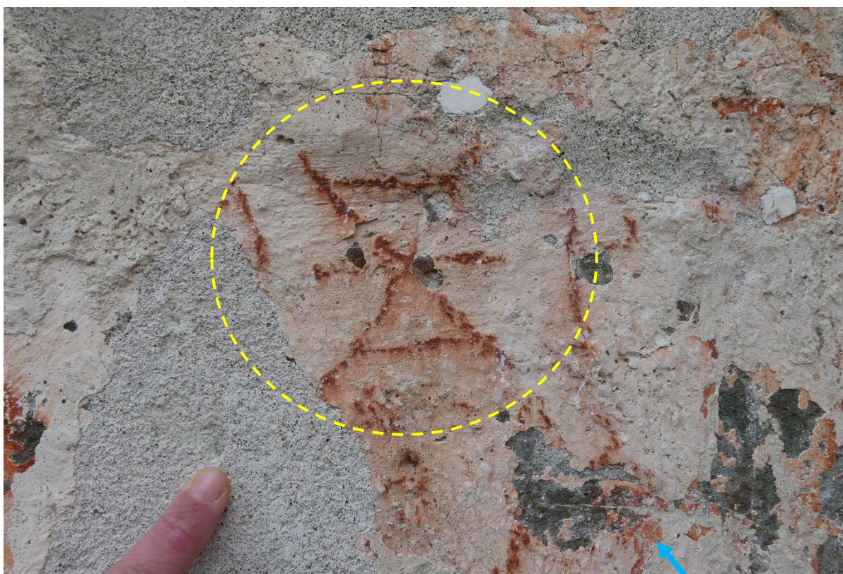
Figur 20: To lag med tegn og merker: Røde merker, malt med rødkritt på et tynt lag kalkslemming (fase IV, merket gult)), som igjen ligger på et annet lag slemming med røde merker (fase III, merket med blå).
