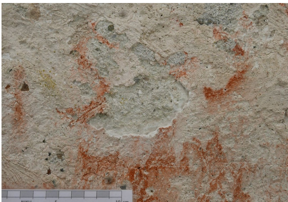
Figur 25: Løs kalklemming er sikret med Ledan TB1.
