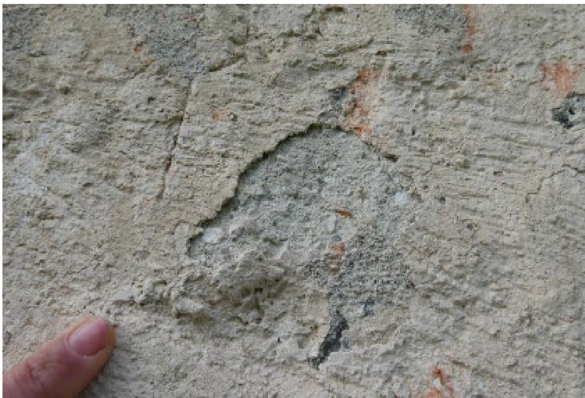
Figur 23: Merker på korets nordfasade, detalj. Stort utfall i opprinnelig kalkslemming. Trolig har også fargespor gått tapt. Foto: Susanne Kaun.
