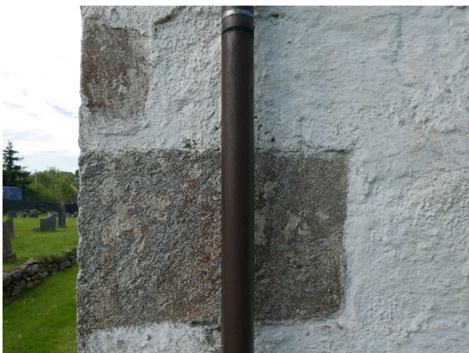
Figur 6: Felt A. På østre kantstein er det bevart kalklag med spor etter røde strek.
