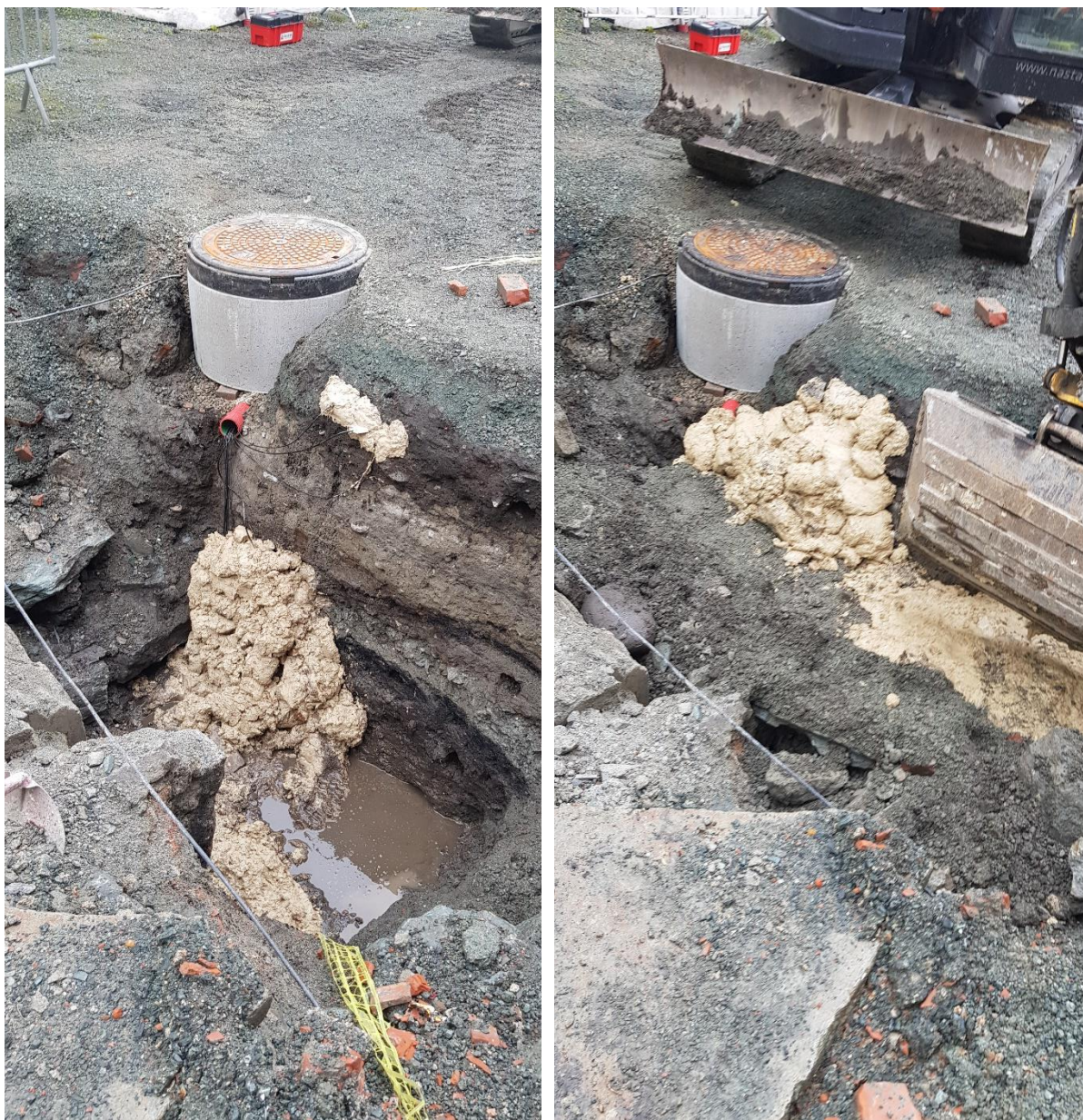
a) b) Figur 13. Komplettering og tildekking med leire av miljøprofil 1.
