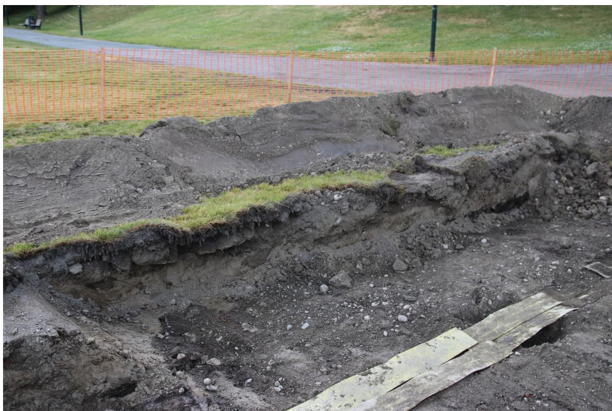
Figur 15: Oversiktsbilde, vestre del av skjøtegrova. Brannlaget er synlig på begge sider av skjøtegrova, mot vest og øst.
