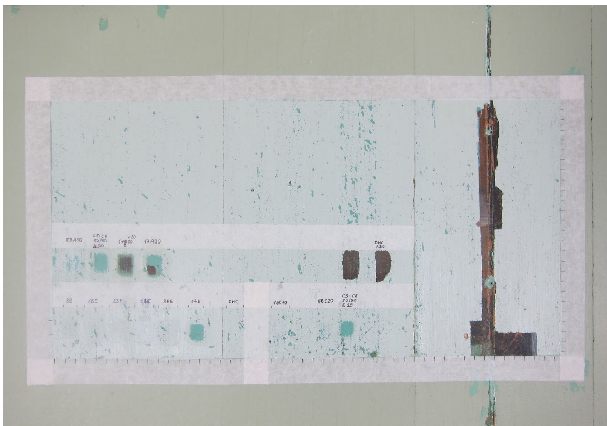
Figur 15 Arbeidssituasjon under løselighetstester på nordveggen (det brune laget er det opprinnelige vi ønsker å avdekke)
