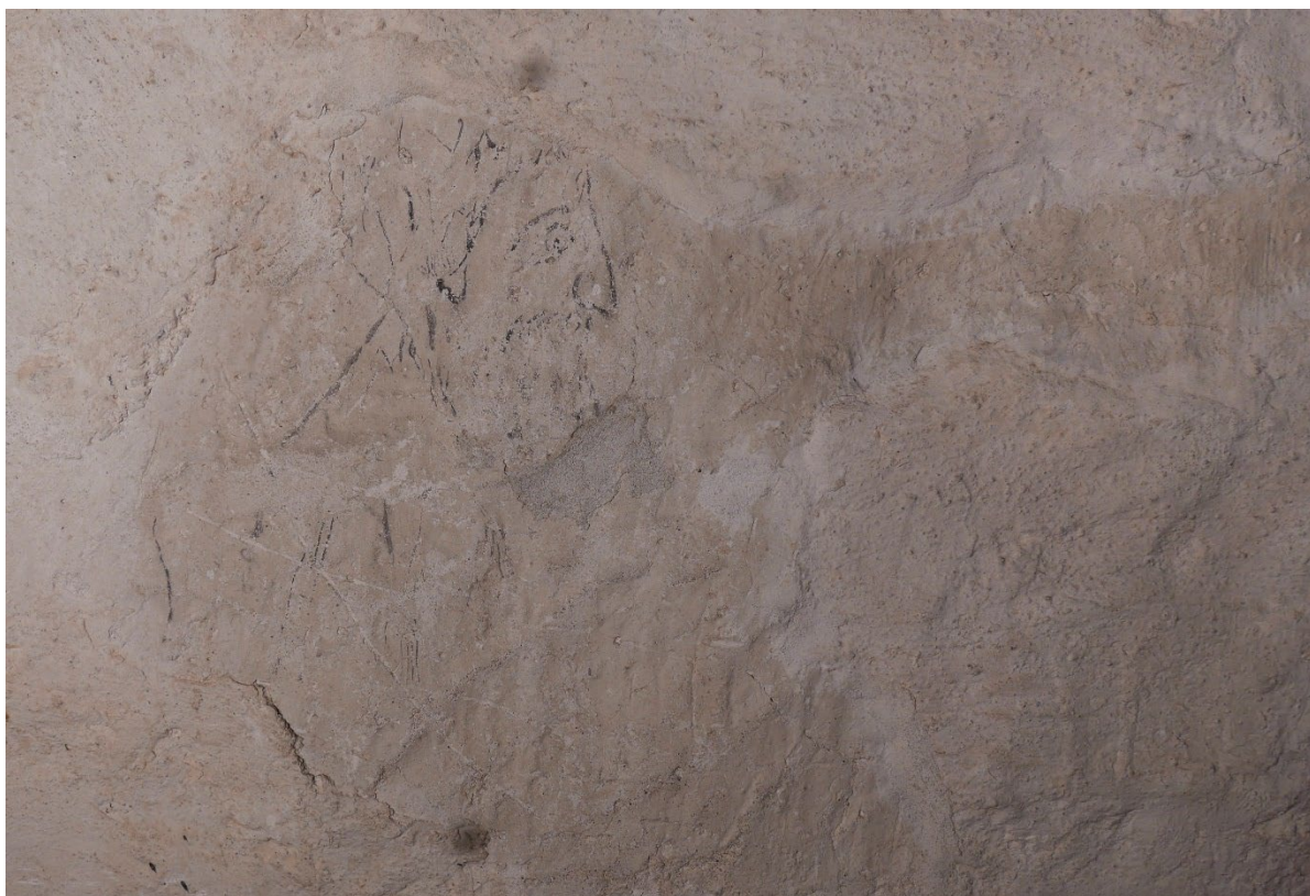
Figur 10: Detalj. Fragment med sorte linier, som kan se ut som en figur. Enkelte avskallinger og skraper. Foto: NIKU
