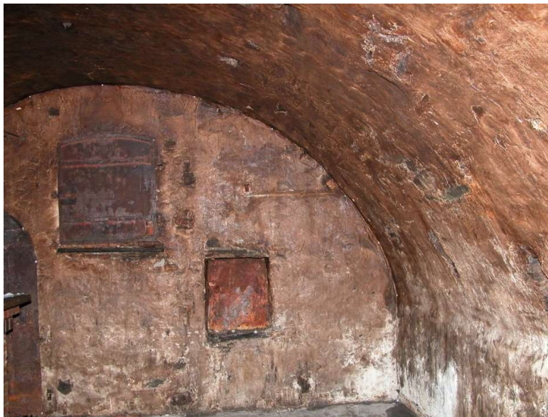
Fig. 4. Østveggen av hvelvkjelleren med vindusåpning.
