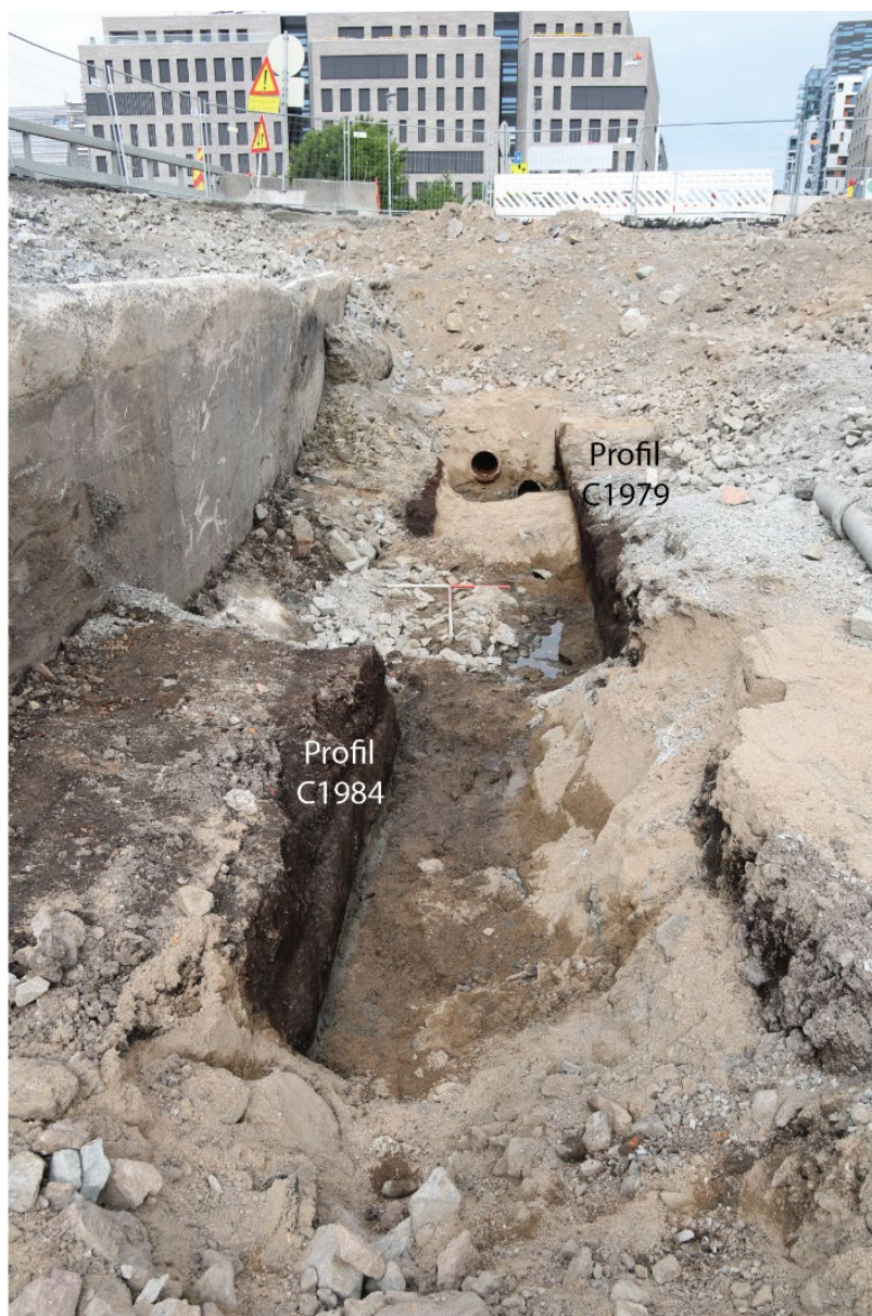
Figur 86: Grøft A med profil C1984 og C1979 etter fjerning av betongrøret. Bilde tatt mot vest av Mark Oldham (Cf53870_NIKU_2102)
