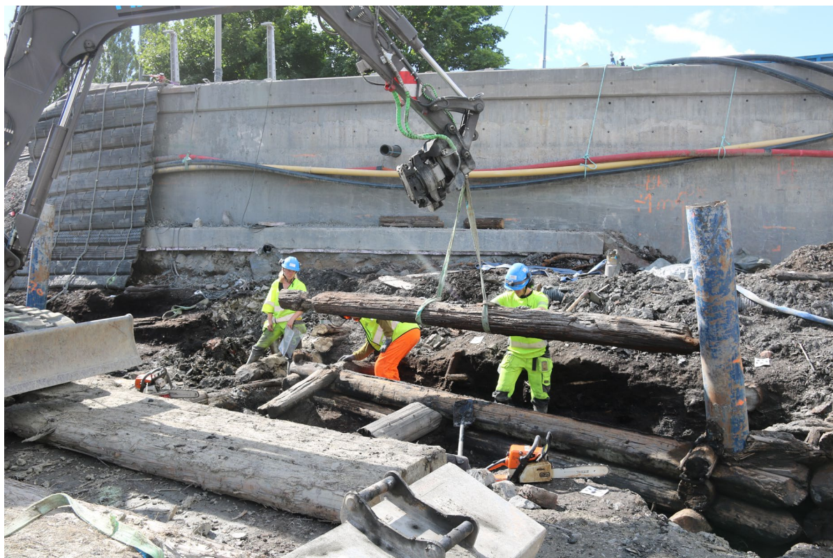
Figur 19: Demontering av SA505072-bolverket fra fase 2 av bryggeanlegget. Bilde tatt mot sør av Tone Bergland (Cf53870_NIKU_3147).
