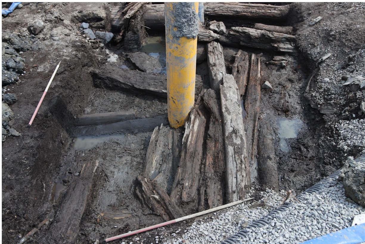
Figur 52: En haug av råtne planker. Bilde tatt mot øst av Solfrid Granum (Cf53870_NIKU_0725).
