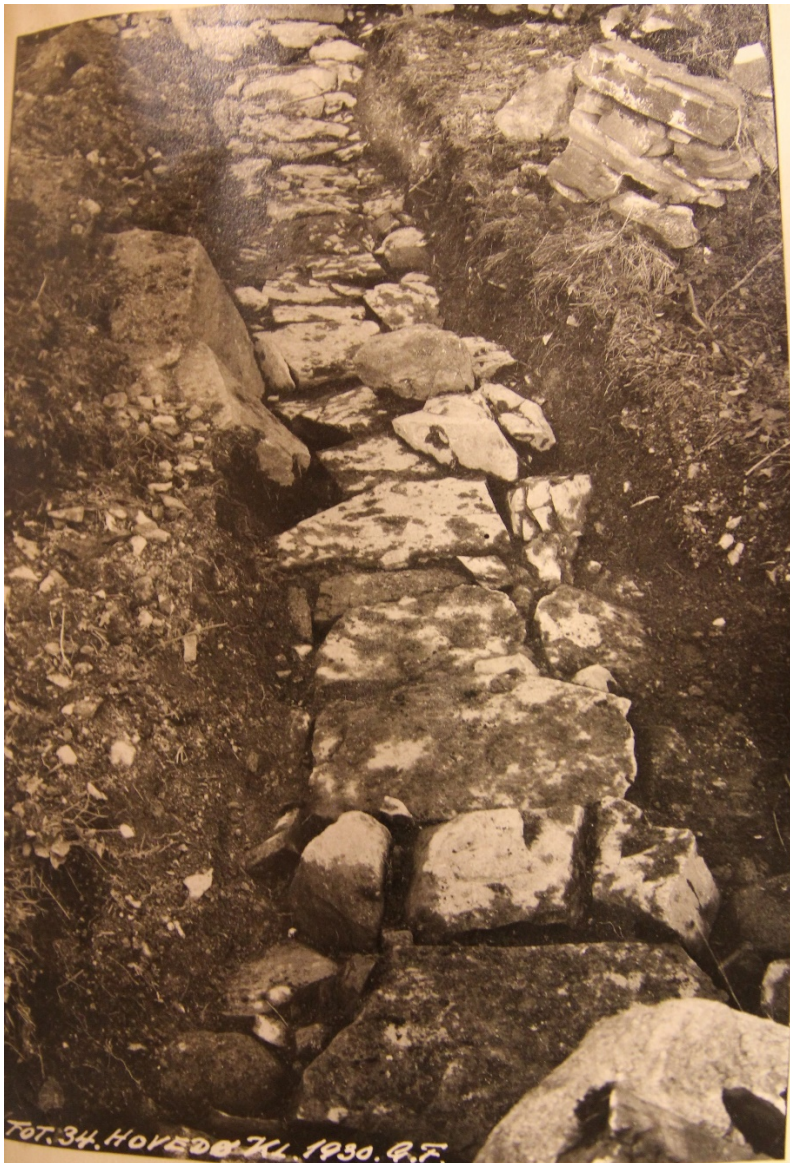
Figur 30: Steinrenne for avløp avdekket i sørfløyen (Fischer 1930).
