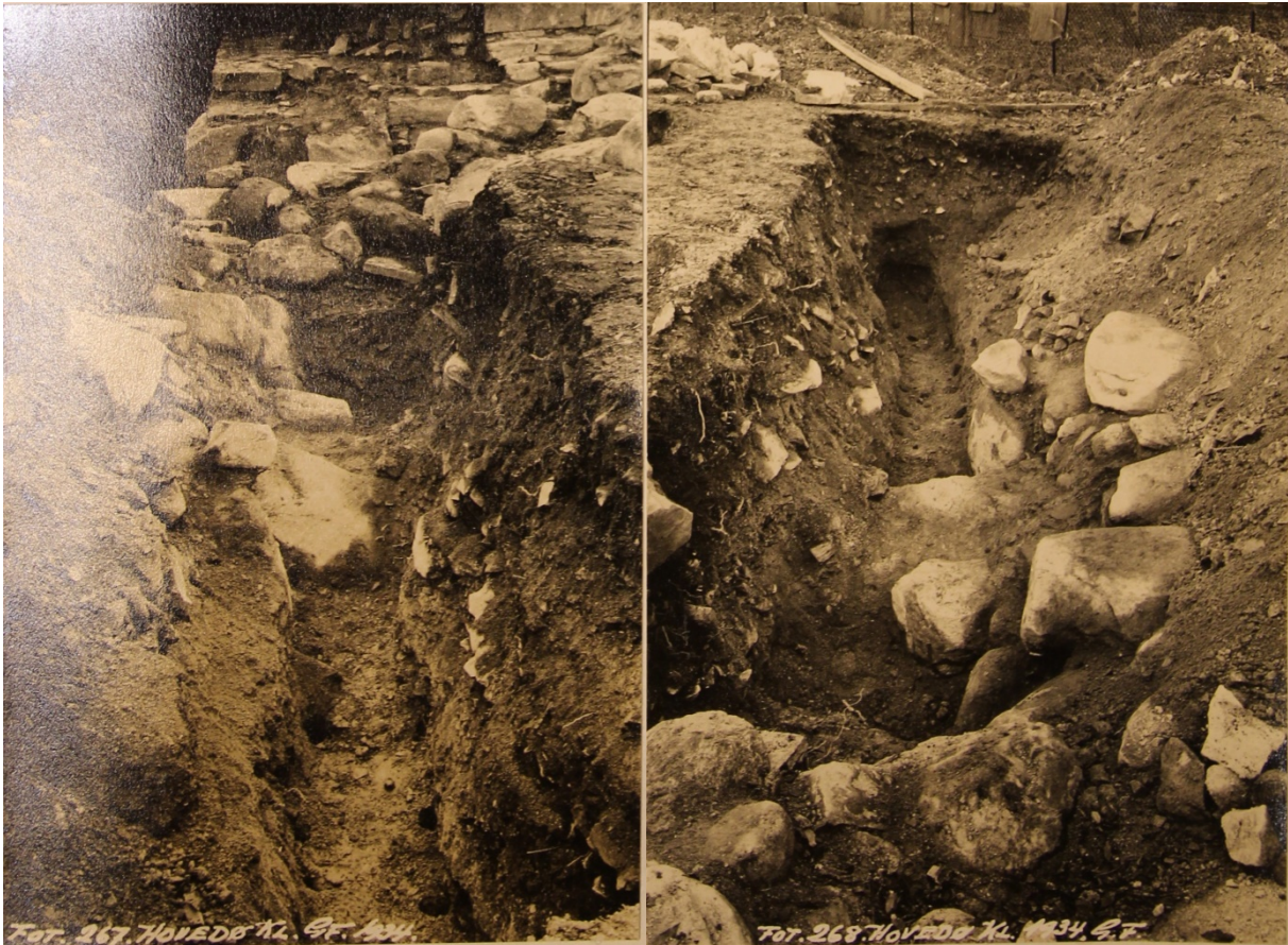
Figur 28A: Fischers søkesjakter etter sakristiets østfundamenter, sett mot sør. Figur 28B: Samme grøft, sett mot nord.
