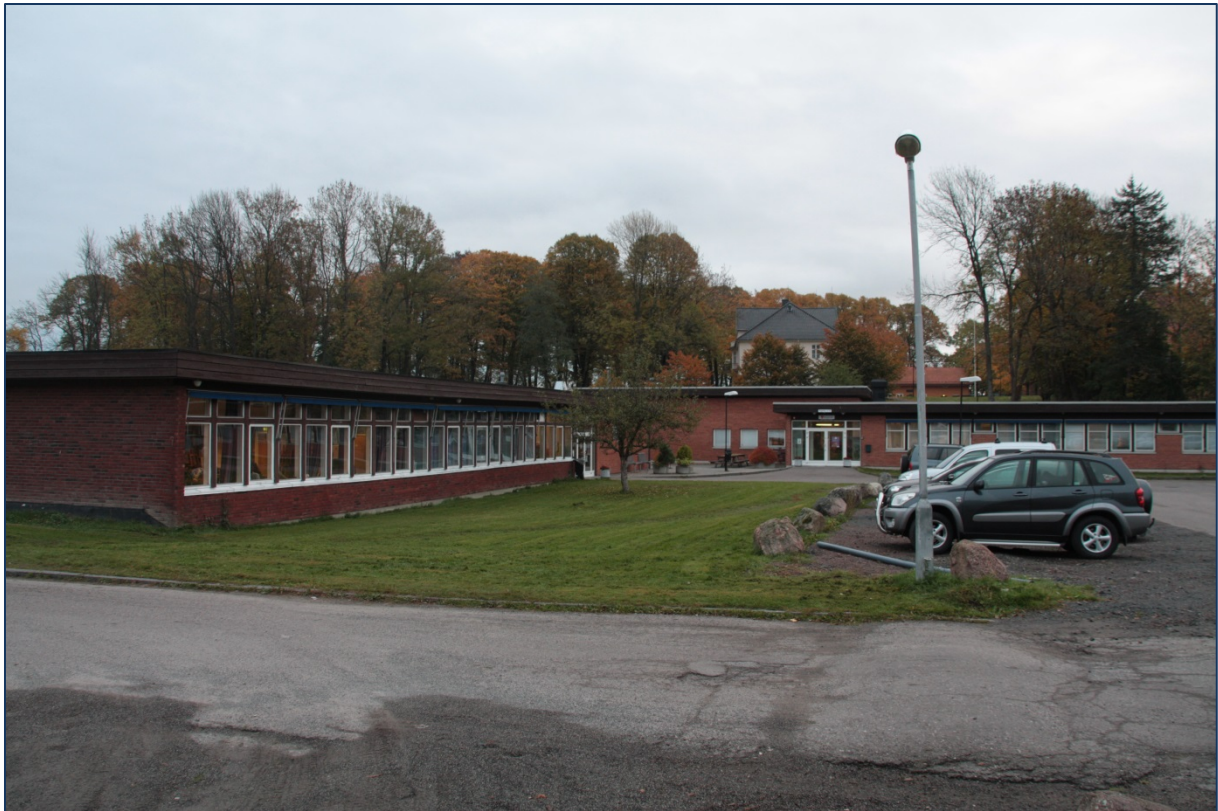
Figur 3: Område 1 og 2 sett mot SØ. Område 1 omfattet plenen mellom skolebygget og steinrekken, område 2 lå på parkeringsplassen til høyre for steinene. Foto: MK/NIKU.
