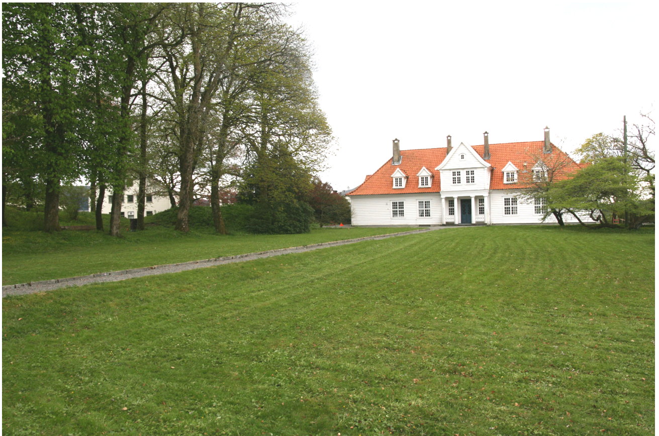
Figur 12: Hagen med hovedhuset sett mot vest. Plenen skjæres av grusveien.
