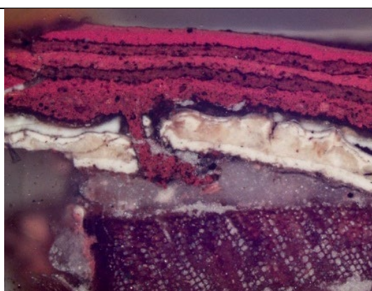
Figur 67 Tverrsnitt av malingslagene på ytre vindusrammen.
