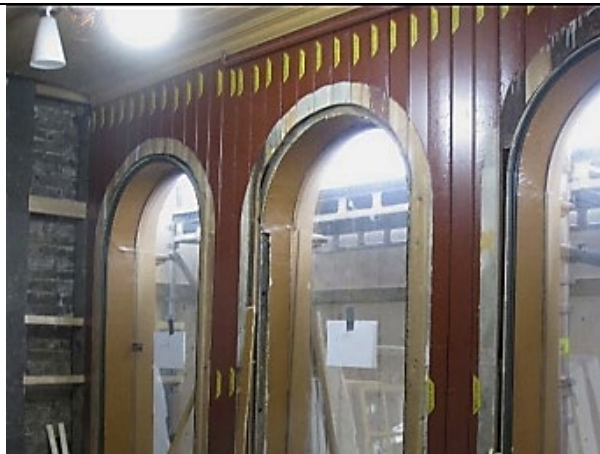
Figur 17 Sørveggen i Taskens første etasje, mot øst. Legg merke til at de forskjellige panelbordene har forskjellig farge der de har vært dekket av vindusgerikter.
