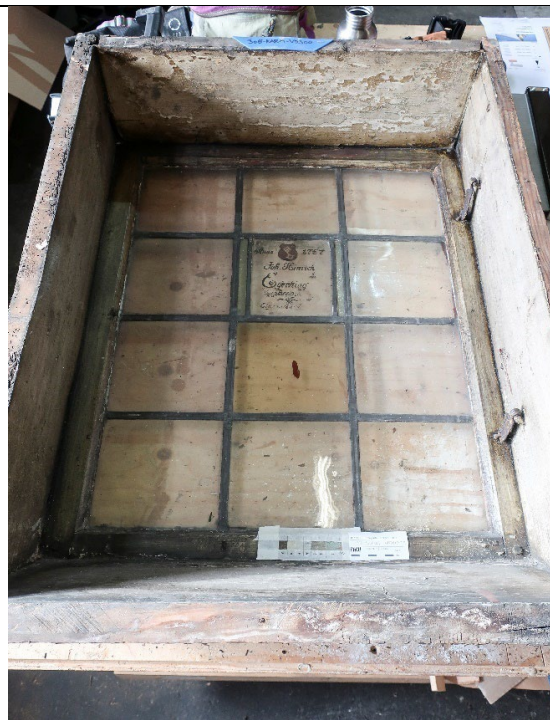
Figur 63 Blyglassvindu i rom 308. Innside.
