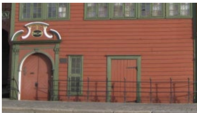
Figur 26 Nedre del av fasaden mot vest i 2016. Kilde: Olstad & Heggenhogen (2016).
