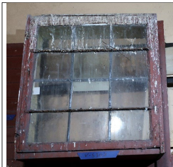
Figur 56 Rom 310. Blyglassvindu fra rom 310 i svalgangen. Ytterside.
