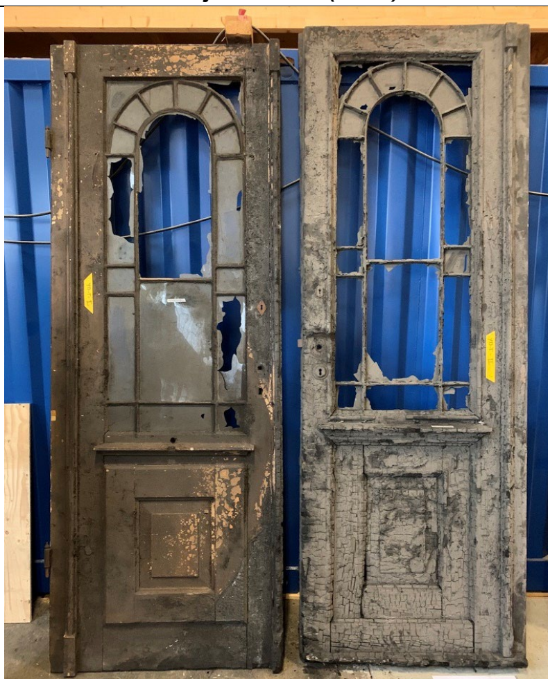
Figur 2 Brannskadete ytterdører fra 1. etasje i Tasken. Dørene er laget i tre. Vindusfeltet er i metall med glass med mønster i matte og blanke områder som ramme rundt de midtre hovedvinduene. Foto: Aina Lille-Langøy. b+b arkitekter.
