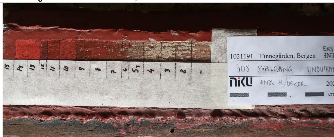
Figur 64 Lagvis avdekking på utvendig vindusramme. Lagene er beskrevet i tabell under.
