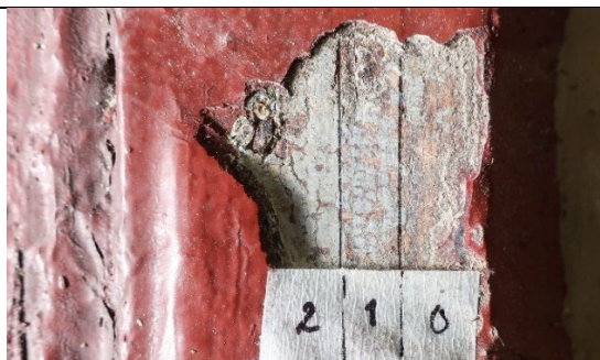
Figur 65 Det første fargelaget er funnet ved hjørnebeslaget, der det har stått mer beskyttet mot vær og/eller tidligere skraping.
