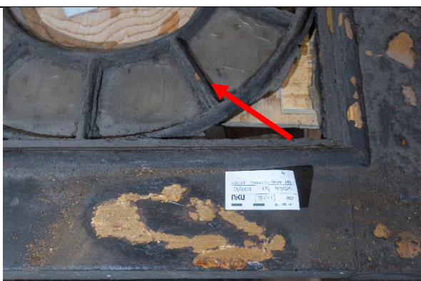
Figur 12 Avdekking på øvre ramtre. Kontrollsjekk på sprossene (rød pil) viste at disse hadde samme brunnyanse som resten av døra, og har sannsynligvis også vært ådret.
