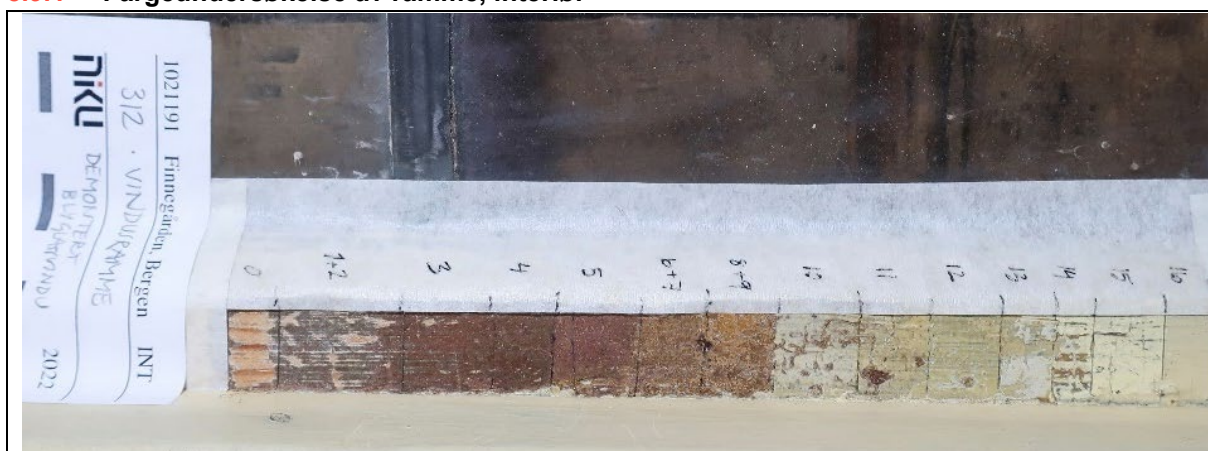
Figur 58 Fargetrapp på ytre ramme, innvendig. Nåværende fargelag, lag 16, er til høyre
