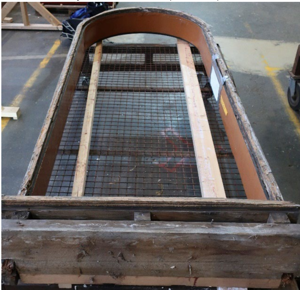
Figur 13 Tasken. Buert vindu i 1. etasje mot sør. Yttersiden.
