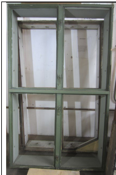
Figur 29 Vindu 2.etg. Rammene er tatt ut.
