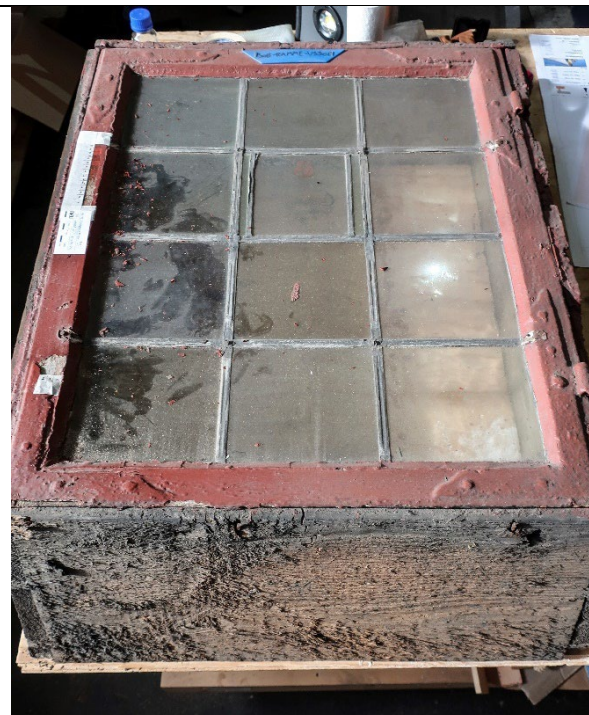
Figur 62 Blyglassvindu i rom 308. Ytterside.
