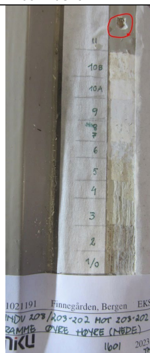
Figur 43 Lagvis avdekking på vindusramme. Øvre høyre ramme (nede). Den røde sirkelen markerer snittuttak.
