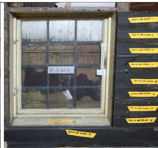
Figur 57 Rom 310. Blyglassvindu fra rom 310 i svalgangen. Innside.
