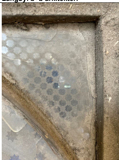
Figur 2 Brannskadete ytterdører fra 1. etasje i Tasken. Dørene er laget i tre. Vindusfeltet er i metall med glass med mønster i matte og blanke områder som ramme rundt de midtre hovedvinduene. Foto: Aina Lille-Langøy. b+b arkitekter.
