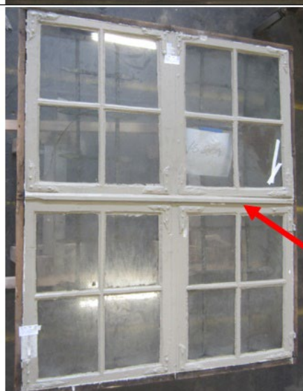
Figur 52 Foto med markering av hvor materialprøver er hentet ut.
