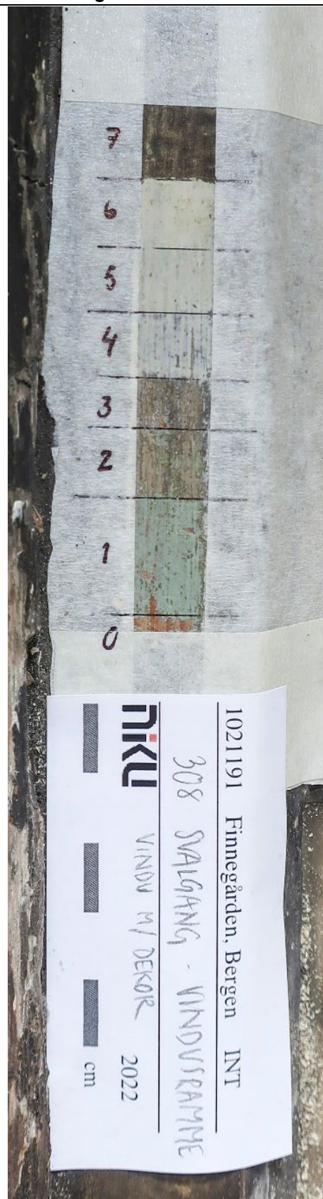
Figur 69 Lagvis avdekking på vindusramme.
