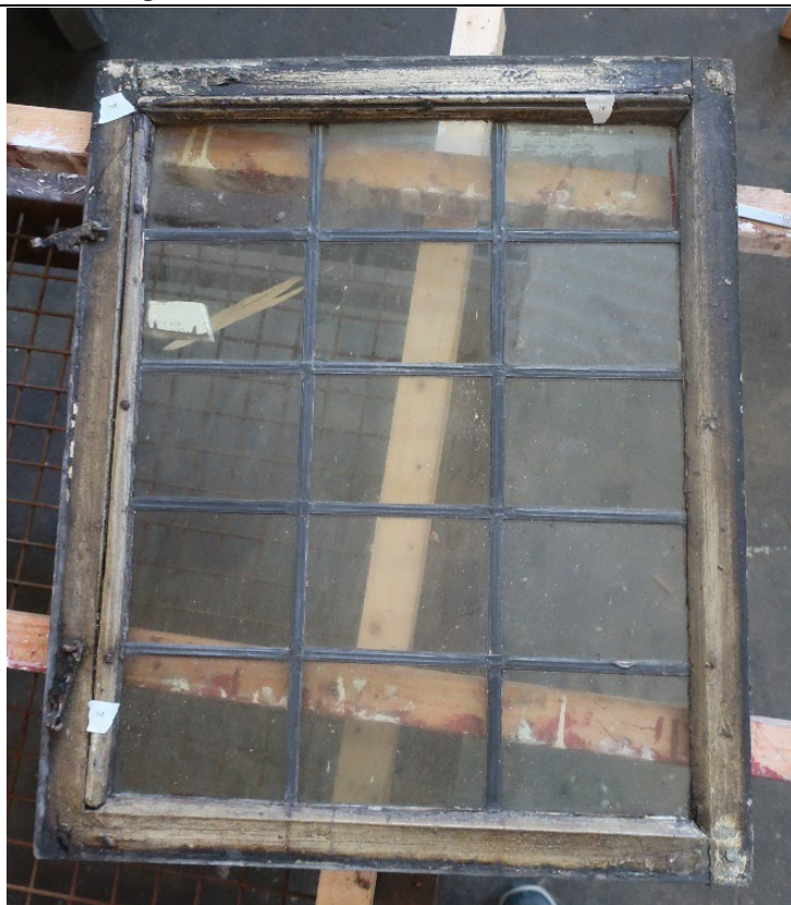
Figur 75 Innvendig ramme på VS200.
