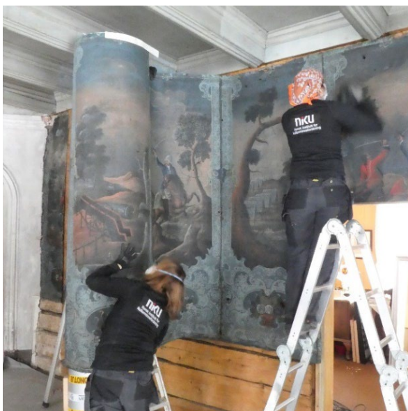
Demontering av 1700-talls lerretstapet i salen på Hovin gård i 2017
