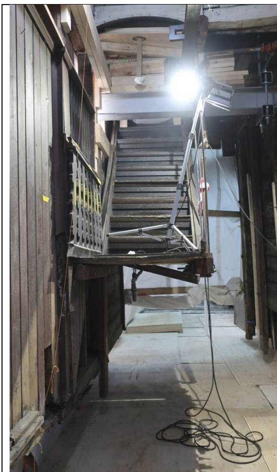
Figur 7 Trappen nedenfor reposit er fjernet.
