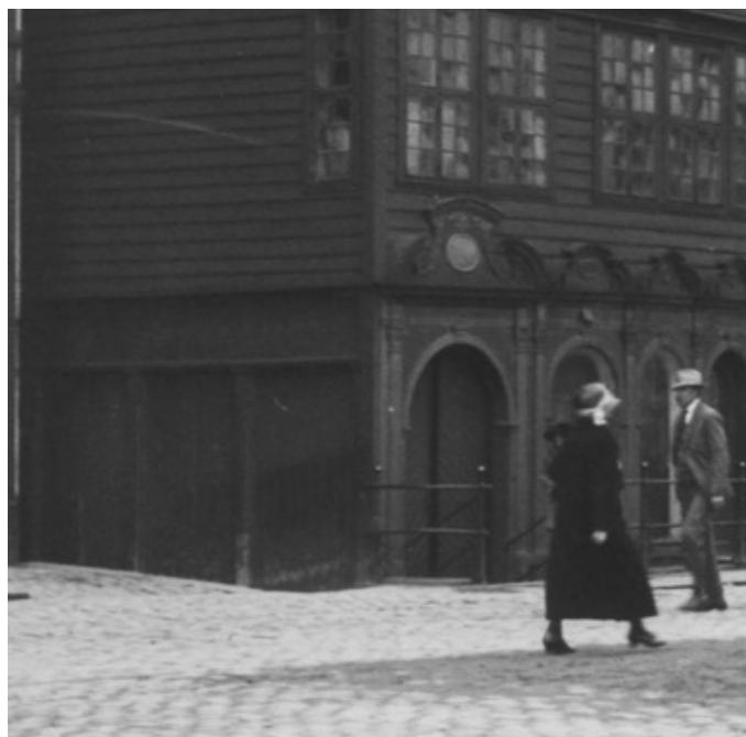
Figur 6 Utsnitt fra foto i figur 5. Døra inn på nordsiden av bygningen er fjernet.
