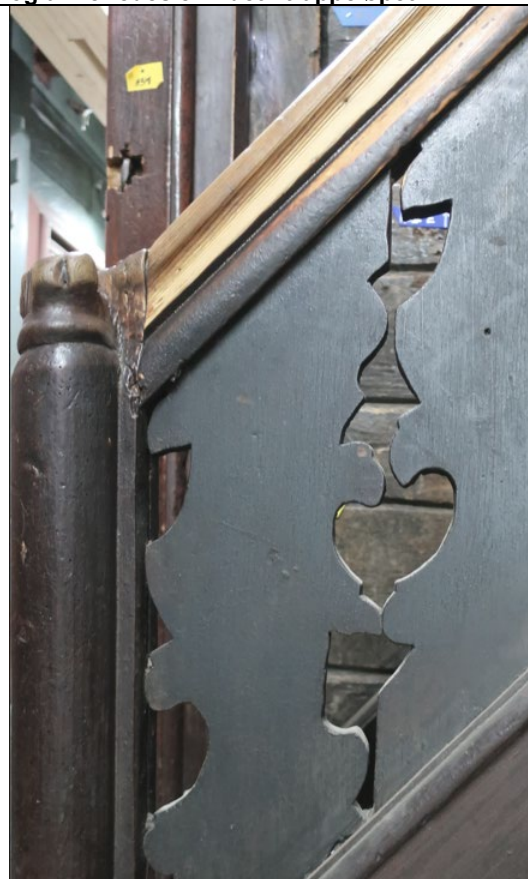
Figur 21 Håndtrevet i trappen mellom 209 og repos er symmetrisk og vurdert å være sekundært.
