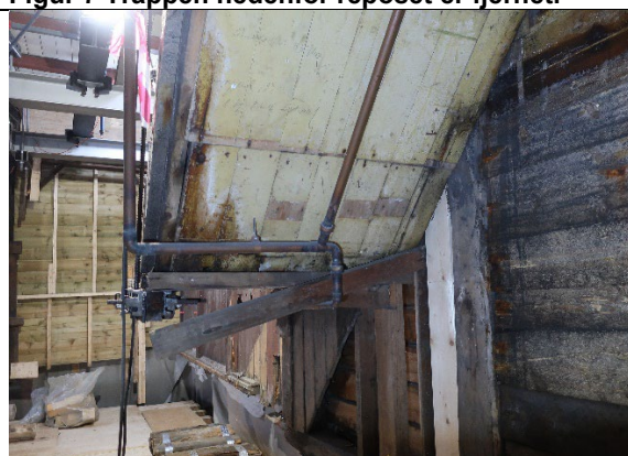
Figur 9 Gjenbruksmaterialer på undersiden av trappen mellom repos og 2. etasje. Bordene er trolig satt på da trappen ble endret og fikk repos.
