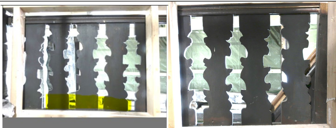
Figur 24 Vestre og østre del av gelender i 3. etg. Denne har 8 balustre av type 2, med noen variasjoner. Beskrevet fra vest: Nr. 1: Kuttet i bredden mot vest. Nr. 2, 3 og 8: Som 1, men er snudd opp-ned. Nr. 4, 6 og 7: Skiller seg fra 1. Nr. 5: Som 4, 6 og 7, men snudd inn-ut. Balustrene står med tilnærmet lik avstand til hverandre. Legg merke til høydeforskjellen på nedre del (markert med gult).
