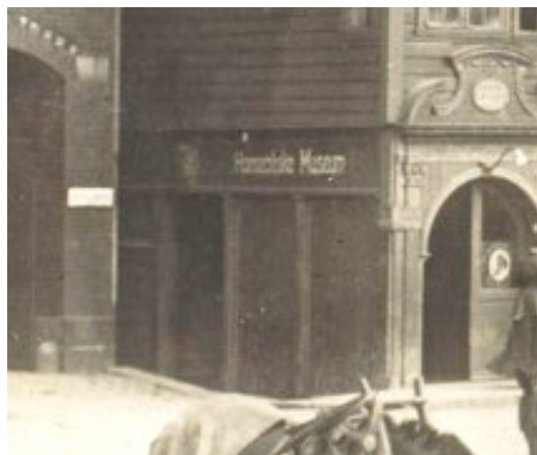
Figur 4 Utsnitt fra foto i figur 3. Døra inn på nordsiden av bygningen sees under skiltet. Skomakeren er på plass. Det betyr at dette er den perioden inngangen til bygningens 2.etasje er på nordsiden og at trappen er bygget inn. Ifølge Koren Wiberg ble Tyskebryggens våpen satt opp over museets inngang i 1888.
