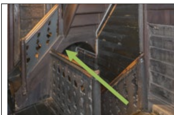
Figur 31 Bue over trappeløpet ned til 1. etasje.
