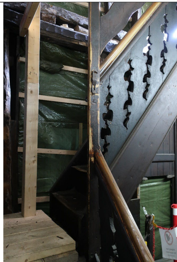
Figur 28 Sekundær stolpe der trappen endrer løp.
