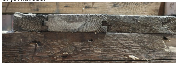
Figur 8 Reposet sett mot nord. Balustre mot nord står fortsatt på plass. Foto nedenfor viser en detalj fra gulvbordene på reposet. Disse har not og fjær og er jevnbrede.
