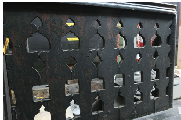
Figur 19 Gelender i 2. etg. Bak går trappen ned til 1. etg. Her er det syv balustre av type 1. Håndtrevet er asymmetrisk. Dette er vurdert å være 1700-talls og annerledes enn det i trappeløpet.
