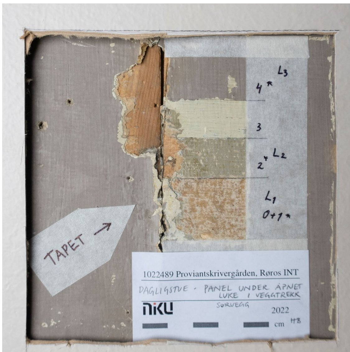
Figur 39. Lagvis avdekning på veggpanelet under sekundære plater. Første lag er en papirtapet, men det har ikke blitt observert mønster i det avdekkede feltet (30 x 25 mm). Tapetet kan også ha hatt limfargestrykk som ikke har vært mulig å avdekke. Ettersom åpningen er laget rett over fotlista er det mulig at de senere malingslagene er malte fotlister og/eller malt brystning, og ikke veggfargen. Foto: NIKU, 2022.
