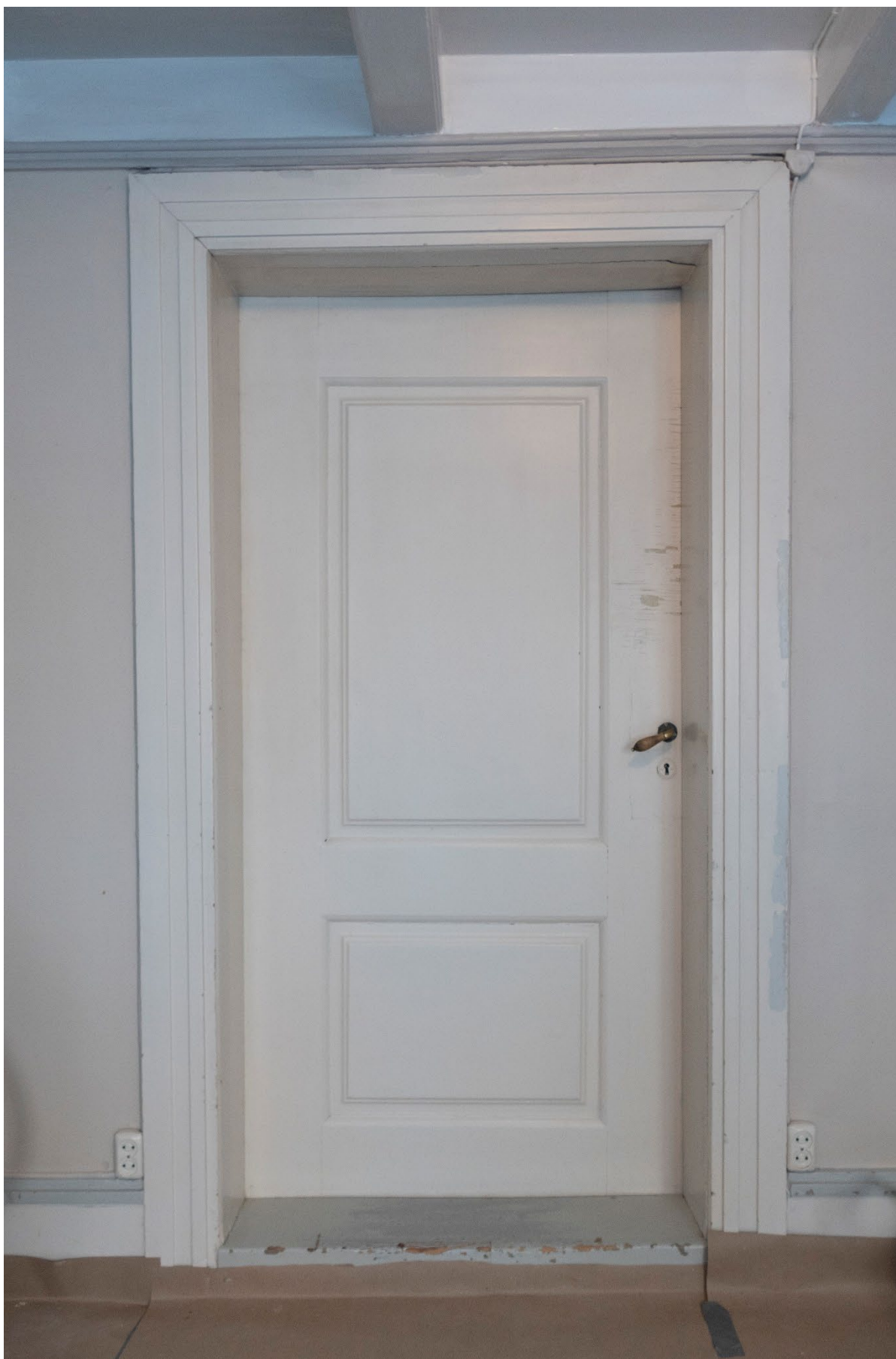
Figur 13 Dør til kjøkken. Døren slår ut av rommet. Foto: NIKU, 2022.
