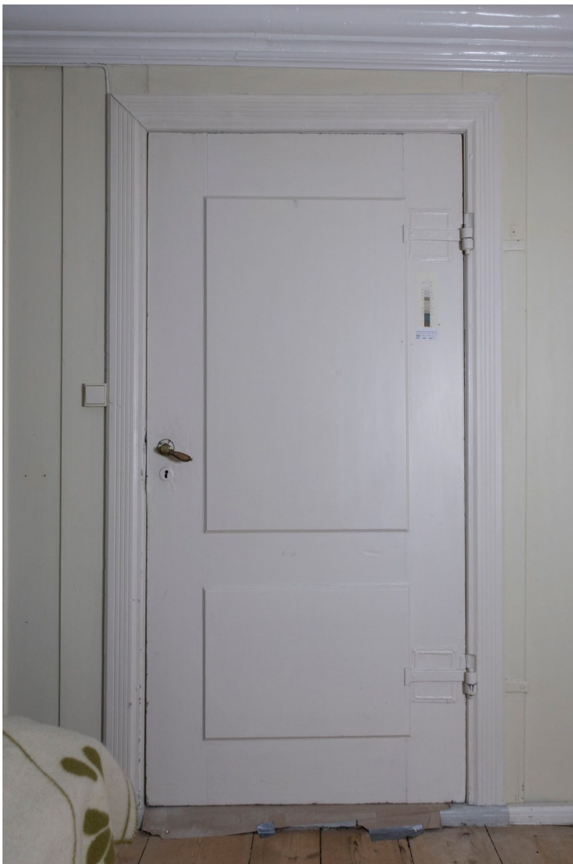
Figur 7 Dør til dagligstuen. Døren slår inn i rommet. Døren har ikke karm, og gerikten i dagligstua er anslaget til døra. Gerikta har riflet profilering, og er trolig eldre enn dørgeriktene i dagligstuen. Hengslene er sekundære. Foto: NIKU, 2022.
