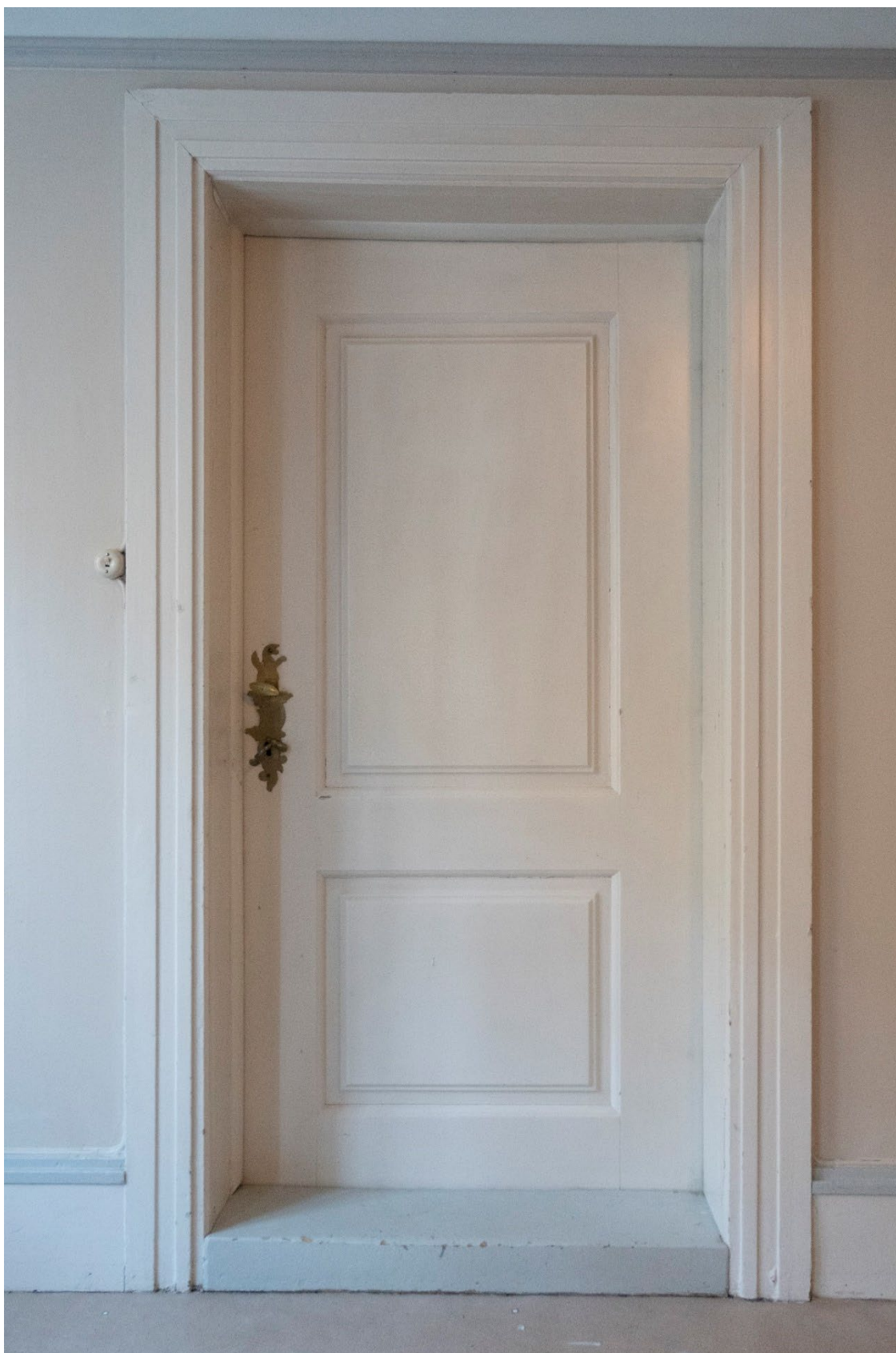
Figur 12 Dør til gangen. Døren slår ut av rommet. Karmen har blitt utforet i to omganger. En av utforingene er satt inn samtidig med geriktene, den andre er senere. Den eldste delen av karmen er den delen som også er anslaget til døra. Foto: NIKU, 2022.
