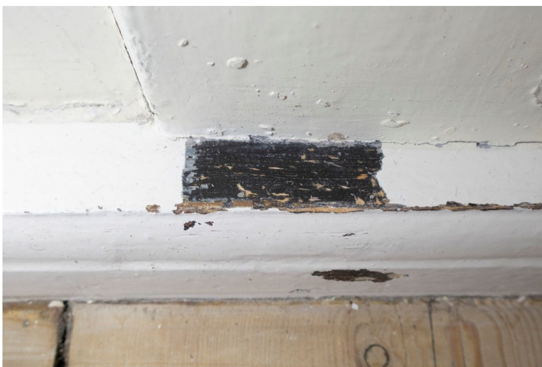
Figur 29 Avdekning av opprinnelig farge på fotlist mellom brannmur og dør til dagligstuen. Det er ikke gjort en lagvis avdekking. Det første laget er en mørk blåsort, og er samme farge som L1 på løpelist og brystningslista. L2 er mørk brun. L3 er samme som L2 på dørgerikt. Etter dette er det hvite malingslag. Foto: NIKU, 2022.
