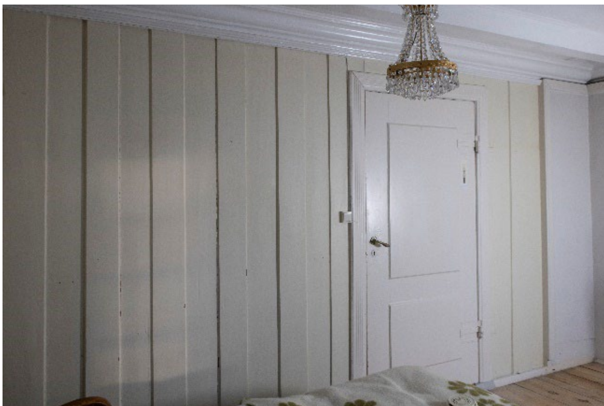
Figur 3 Vegg mot nord. Vekselpanel. Opprinnelig, lav fotlist bevart på brannmur og mot døra. Foto: NIKU, 2022.
