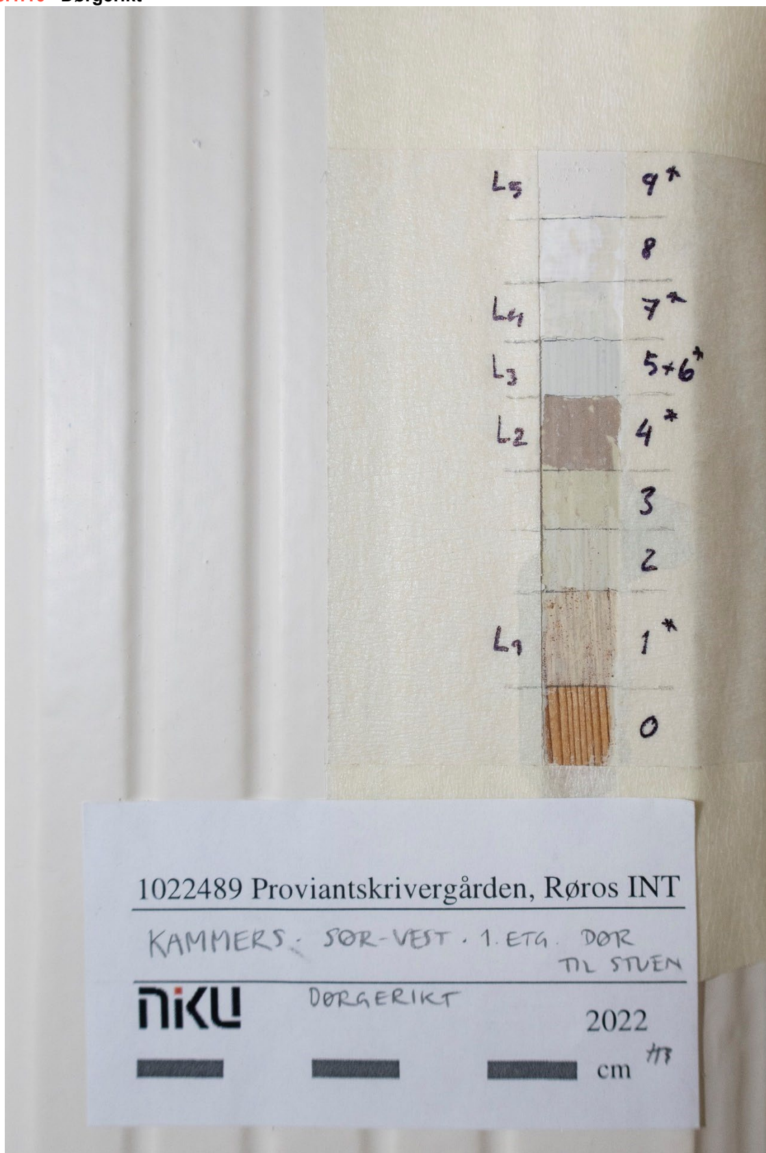
Figur 30 Lagvis avdekking på dørgerikten. Gerikta er senere enn dørbladet. Dette gjelder også dørhengslene som går bak gerikten. Gerikta og brannmurslisten har Luis-seize-preg, med riflede profiler. Foto: NIKU, 2022.
