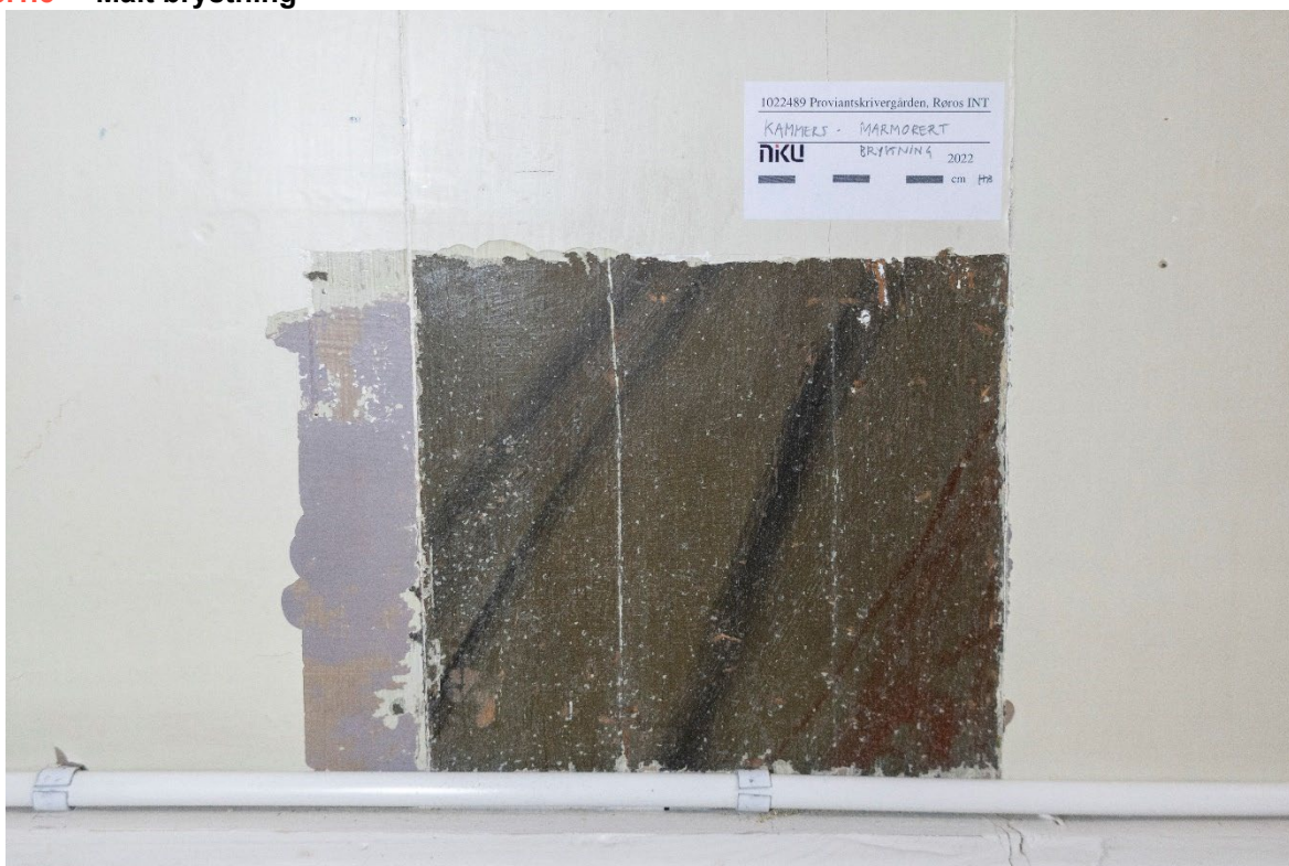
Figur 26 Avdekking av marmorert brystning. De malte brystningene er malt ca. 80 cm opp fra nåværende gulv. Marmoreringen er også gjort på vekselpanel mot nord. Foto: NIKU, 2022.
