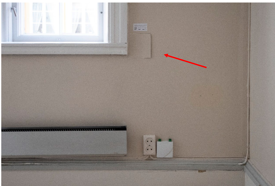
Figur 38 Plassering av åpning i sekundære plater på vestveggen. Foto: NIKU, 2022.
