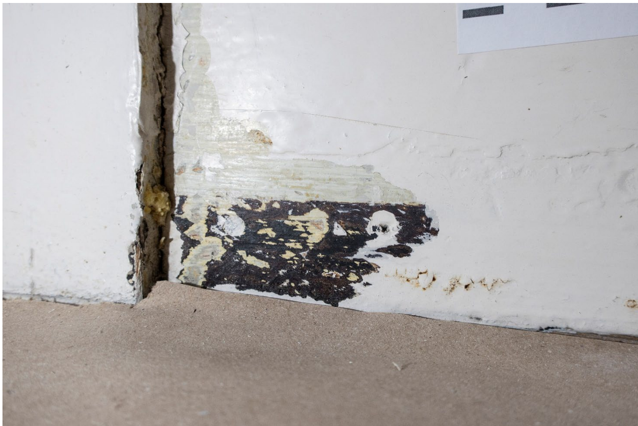
Figur 44 Avdekket malt feielist på fronten av fotlista. Feielista ble også malt ut på dørgerikta. Første malte feielist hører til lys grå fotlist (L3). Foto: NIKU, 2022.
