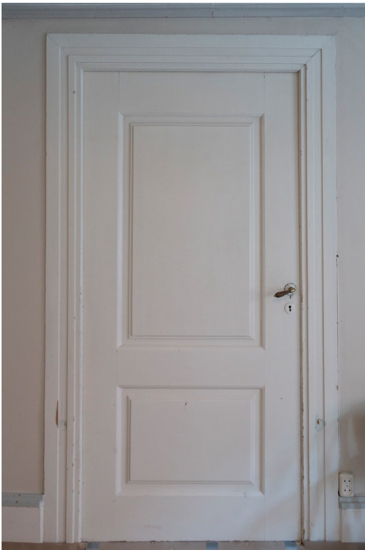
Figur 14 Dør til kammers. Døren slår ut av rommet. Døren har ikke karm, og gerikten i dagligstua er anslaget til døra. Foto: NIKU, 2022.
