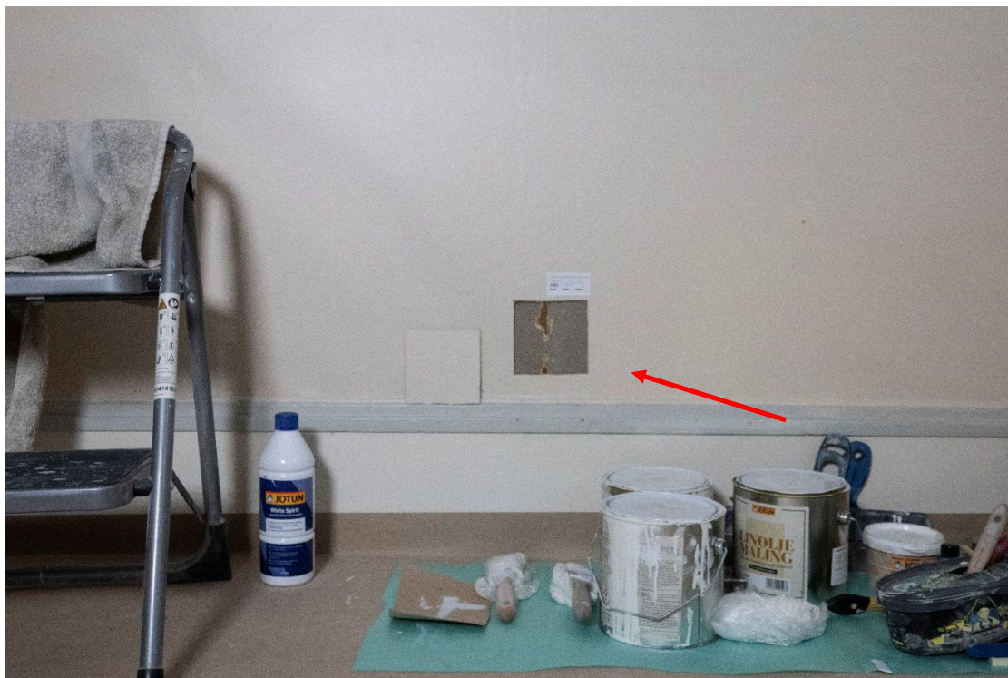
Figur 37 Plassering av åpning i sekundære plater på sørveggen. Foto: NIKU, 2022.
