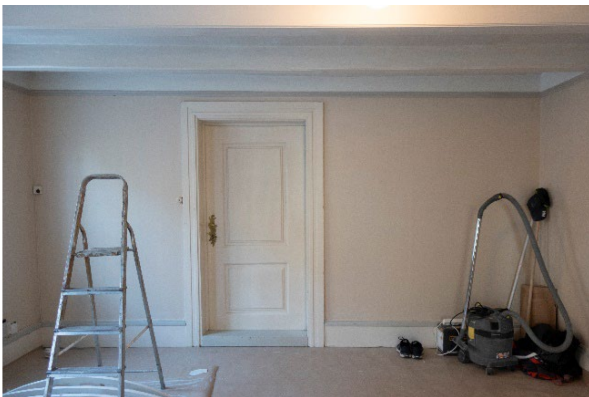
Figur 9 Vegg mot nord. Foto: NIKU, 2022.
