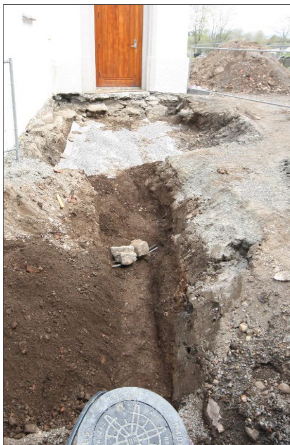
Figur 14. Sjakt 3, grøft mellom kum og sjakt 2, ferdig grave. Sjakt 2 i bakgrunnen. Foto mot aust.
