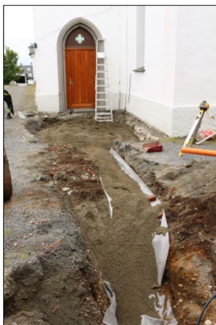
Sjakt 4 og 5, gjenfylt med sand. Mot aust.
