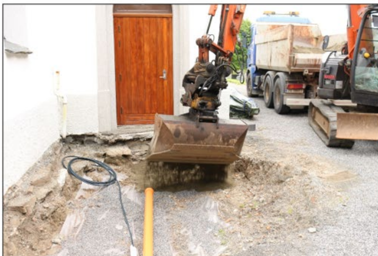
Figur 2. Sjakt 2, Gjenfylling. Mot aust.
