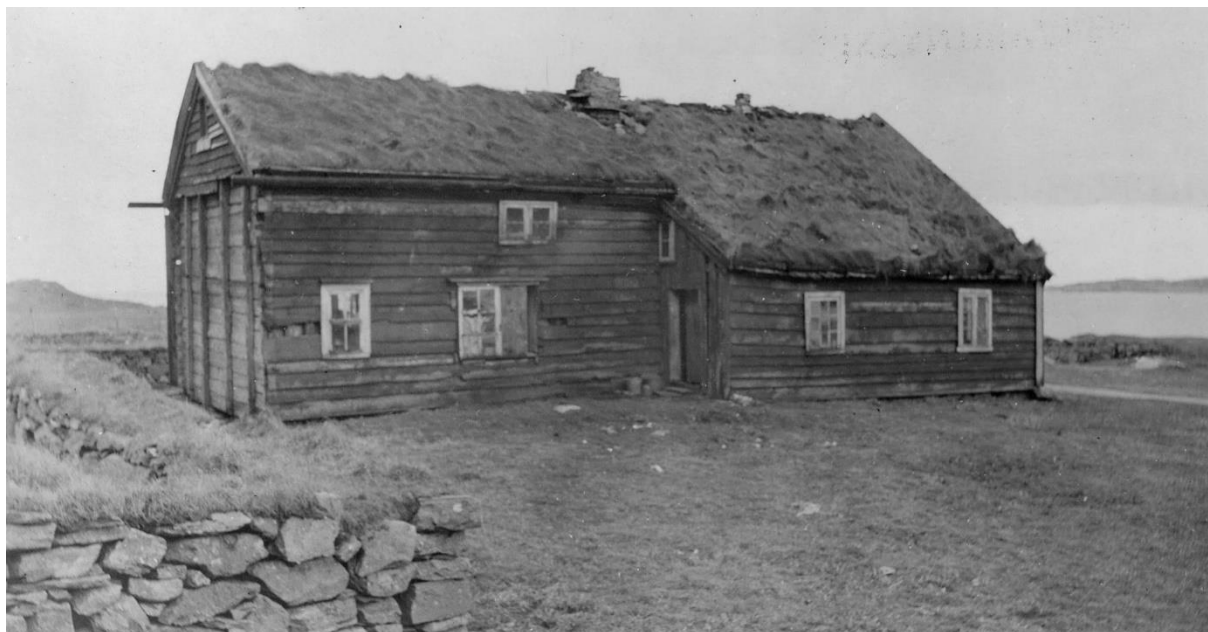
Figur 14 Bildet som viser murpartiet i forgrunnen hvor gangstien ble observert. Ukjent fotograf og tid
