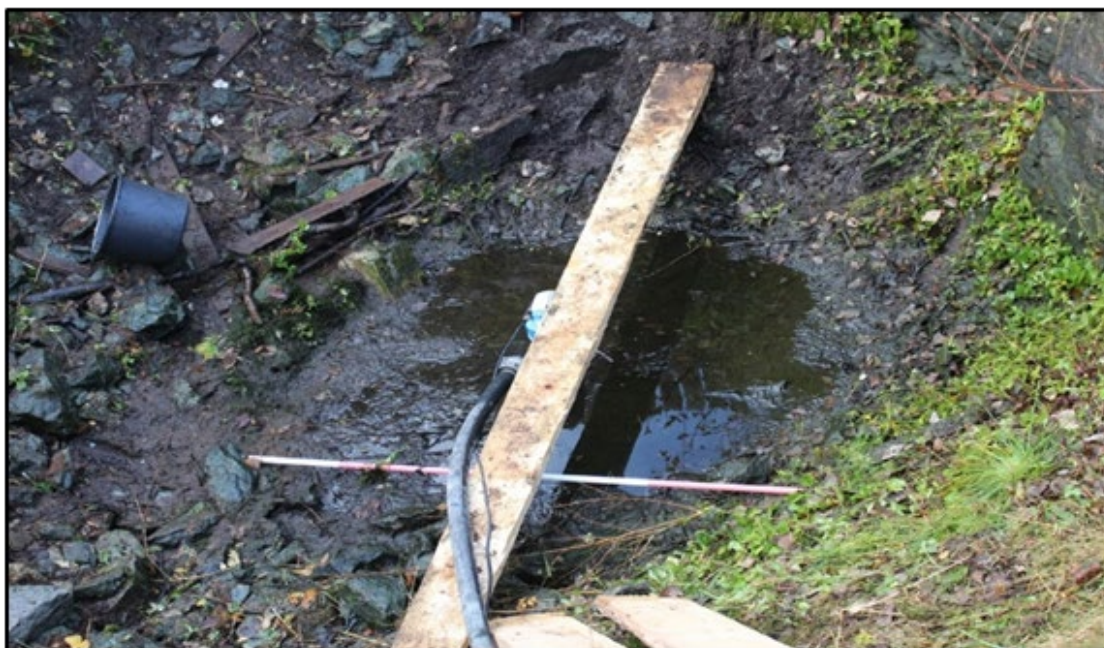
Figur 7. Brønnen med overflate etter at vann blitt pumpet ut og støtteplanke lagt ut. Foto: nik_ark_33924
