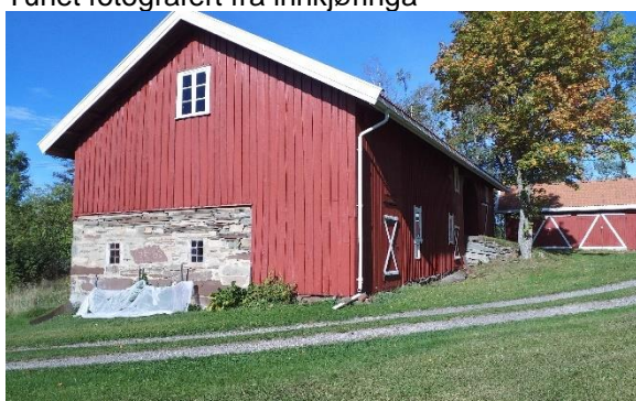
Driftsbygningen med fjøsdelen i naturstein.
