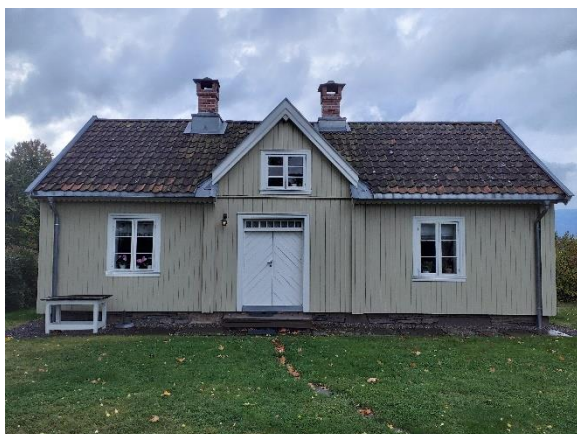
Våningshuset på Sørbråten. Fasade inn mot tunet
