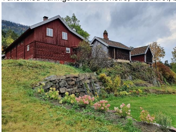
Anlegget sett fra nordvest.
