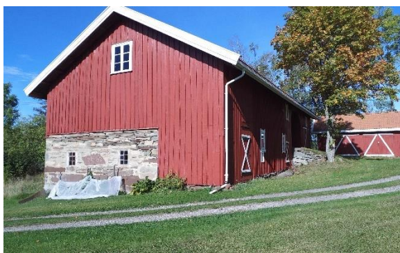
Driftsbygningen med fjøsdelen i naturstein.
