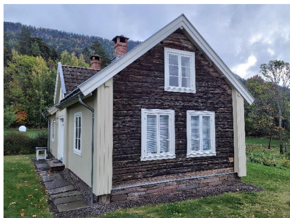
Våningshuset på Sørbråten. Fasaden mot vest.
