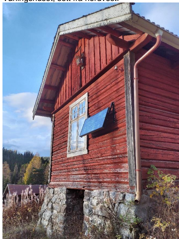
Våningshusets fasade mot sør
