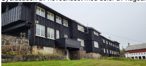
Hovedhusets fasade mot øst, driftsbygningen ses i bakgrunnen.
