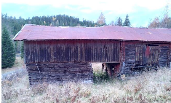
Søndre del av driftsbygningen, fasade mot øst
