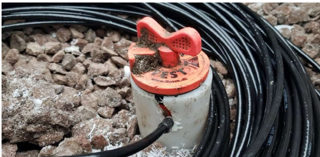
Figur 4. Eksempel på kabelføring
