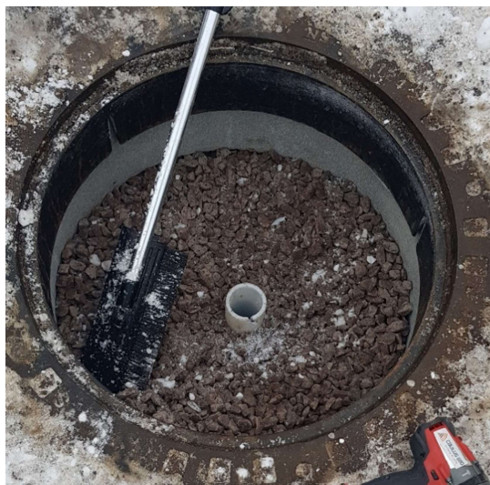
Figur 3. Eksempel på kumring ovenpå miljøbrønn
