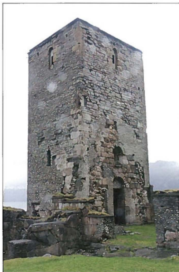
Albanuskirkens vesttårn med den bevarte vestveggen av den eldste Albanuskirken (nedre, kvaderkledd del av tårnet). Oppmålingstegningene det vises til i teksten er imidlertid av det ytre murlivet. Dette er kun synlig inne i tårnet som stammer fra en senere fase. Vanndråpene på kameranlinsen viser til de friske værforholdene på øya. Foto tatt mot nordvest av Knut Paasche 2009.
